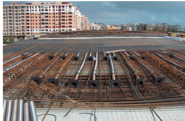
Fig. 3b: Postesado de losa
