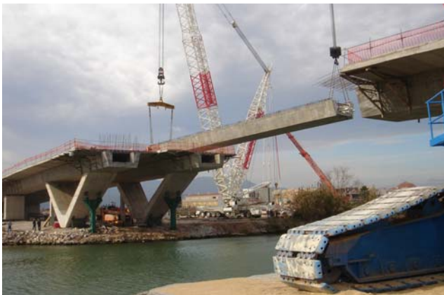
Fig. 3a : Colocación de viga central.
