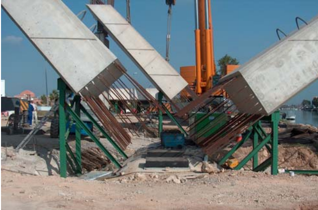
Fig. 2a: Pila en V: montaje de los fustes
