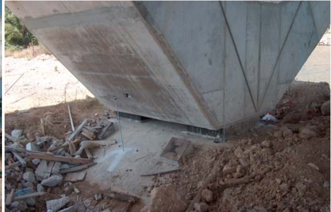
Fig. 2b: Detalle de la articulación en base
