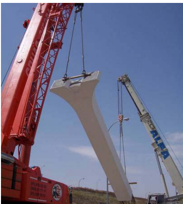
Fig. 3. Montaje de pila prefabricada
