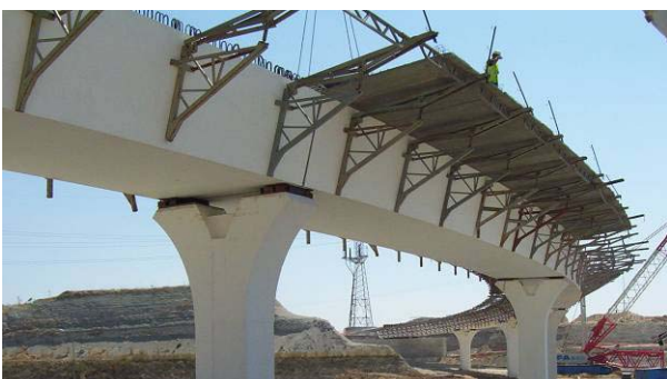
Fig. 5. Montaje de prelosas sobre jабalcones provisionales
