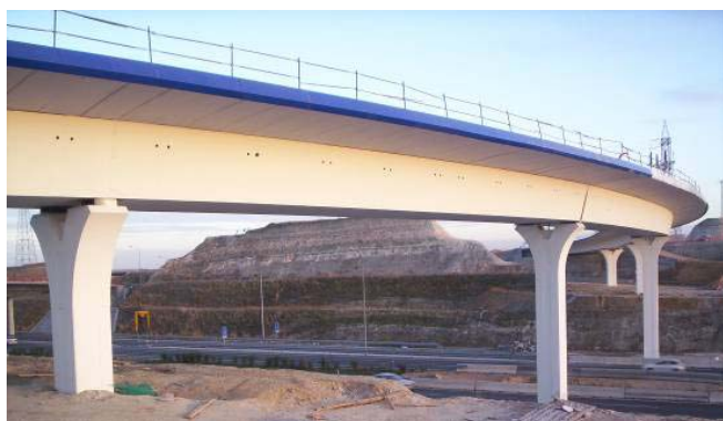
Fig. 1. Vista general del puente
