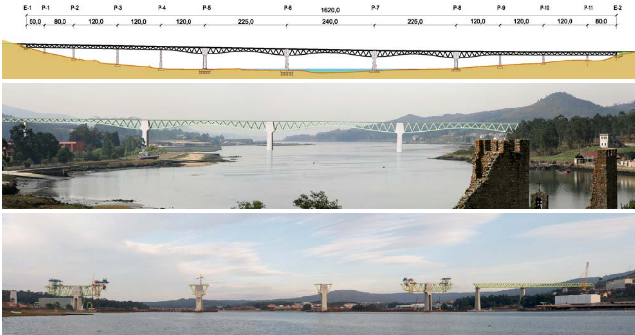
Figuras 1a, 1b y 1c. Alzado, fotomontaje y estado actual del Viaducto sobre el río Ulla (dic. 2013)
