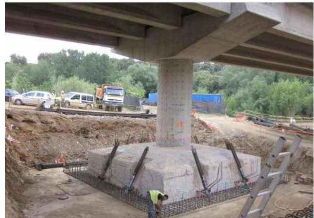
Figura 14. Ferrallado del nuevo encepado tras la ejecución de los micropilotes.
