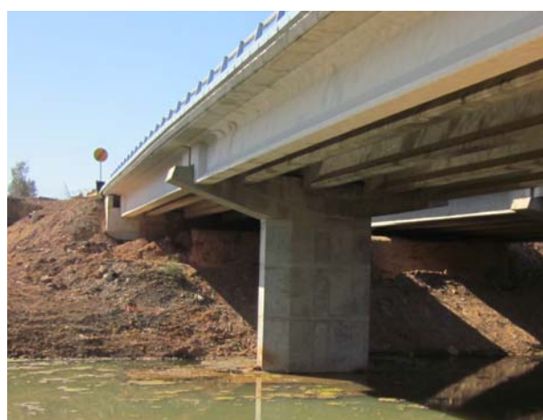
Figura 18. Vista general de subestructura totalmente ampliada, incluso con tablero ejecutado, ya en servicio.
