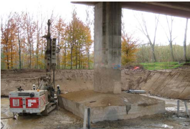
Figura 13. Ejecución de micropilotes para el refuerzo de las cimentaciones.
