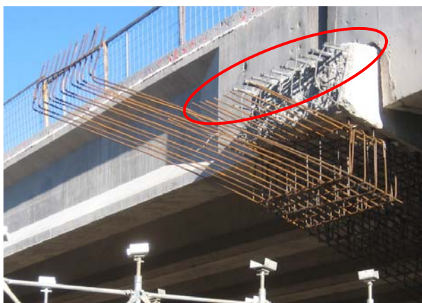
Figura 15. Detalle de conexión de micropilotes a cimentación existente.
