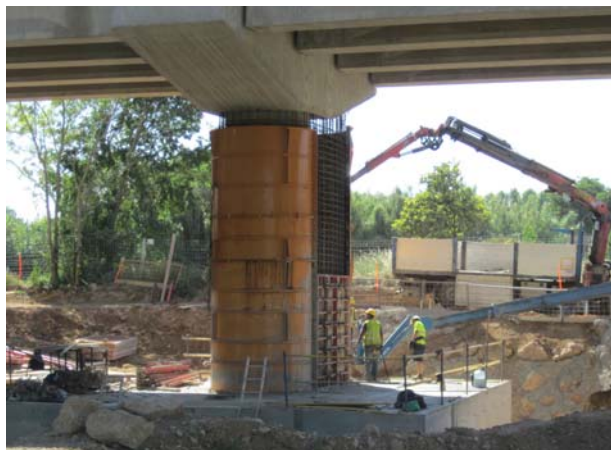
Figura 16. Ejecución de alzados de pilas.
