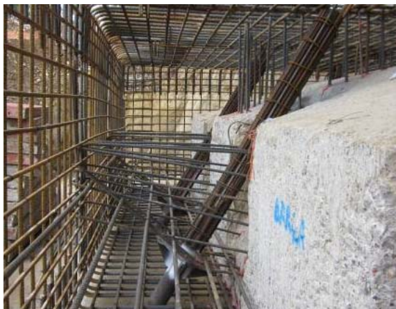
Figura 15. Detalle de conexión de micropilotes a cimentación existente.
