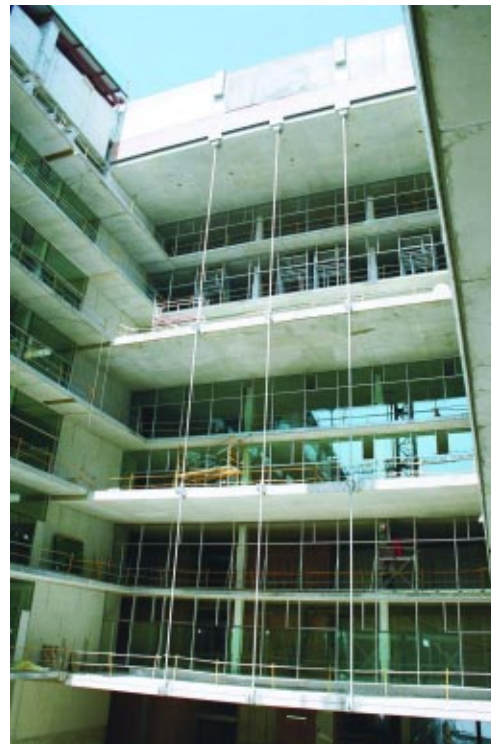
16. Interior del sector I colgado con dos HEM 300 y tres tirantes de 76 mm de diámetro.
