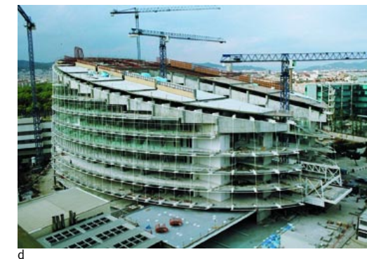
6. Secuencia del proceso constructivo. a. Ejecución de forjados apeados (septiembre 2003). b. Ejecución de estructura superior de cuelgue (enero 2004). c. Colocación tetones superiores de cuelgue y enganche de tirantes a estructura de cuelgue (abril 2004). d. Desapeo y cuelgue del edificio (septiembre 2004). e. Ejecución de fachada exterior (diciembre 2004). f. Fachada exterior concluida (marzo 2005).
