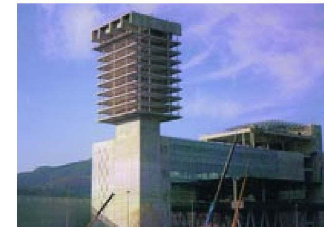
1. Procés constructiu ascendent descendent. Torres de Colón de Madrid. 2. Torre penjada del Centre d'Acollida i Congressos de Bilbao.
