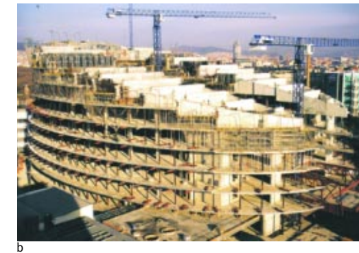
6. Seqüència del procés constructiu. a. Execució de forjats apuntalats (setembre 2003). b. Execució d'estructura superior de penjada (gener 2004). c. Col·locació de pius superiors de penjada i enganxada de tirants a estructura de penjada (abril 2004). d. Desapuntament i penjada de l'edifici (setembre 2004). e. Execució de façana exterior (desembre 2004). f. Façana exterior acabada (març 2005).
