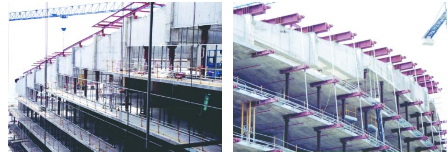
19. Riostra interior. 19. Riostra interior. 19. Inner strut. 20. Doble riostra exterior. 20. Doble riostra exterior. 20. Double external strut.
