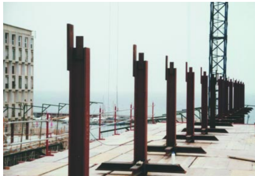
14. Detall de transversers en tirants interiors i unions de tirants interiors de sectors II i III amb tapajunts.
