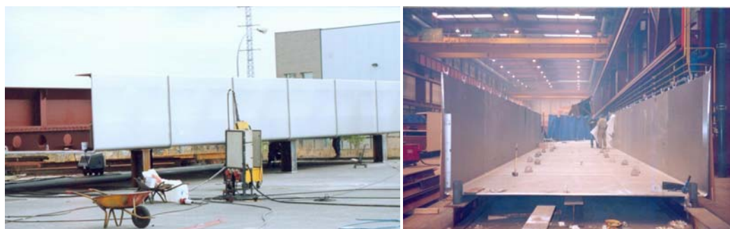
Figura 4: Grupo de dovelas de inoxidable ya soldadas entre sí.
