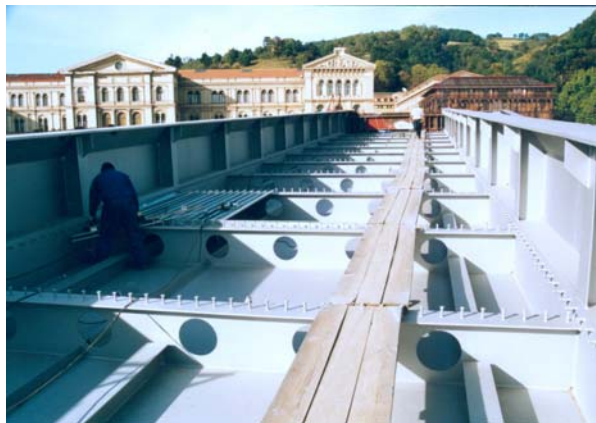
Figura 5: Interior de la pasarela totalmente pintado.
