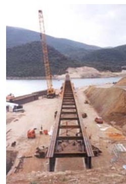
Fig.12 y 13: Viaducto empujado del Picado (cortesía de Fhecor/Dragados)
