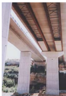
Fig.10 y 11: Viaducto Betxi-Borriol. Montaje de sección doble viga
