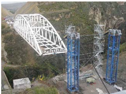
Fig.30 y 31: Lanzamiento del puente de Lanjarón y del Pabellón Puente de ExpoZaragoza 2008 (cortesía de Dragados)
