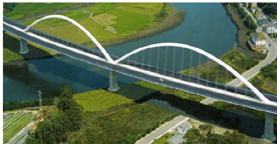
Fig.20: Viaducto de Navia (cortesía de FCC)
