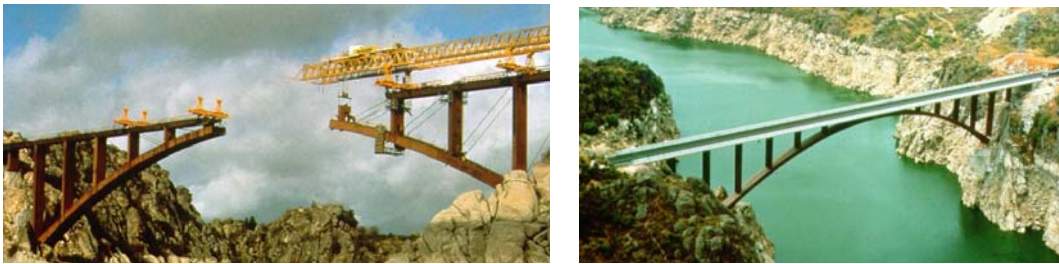
Fig.18 y 19: Arco Mixto de Ricobayo (cortesía de Ferrovial-Agromán)
