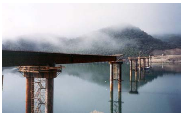
Fig.12 y 13: Viaducto empujado del Picado (cortesía de Fhecor/Dragados)
