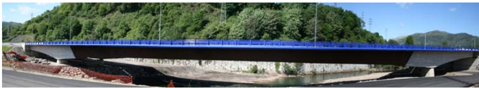
Fig.28: Puente sobre el río Nalón
