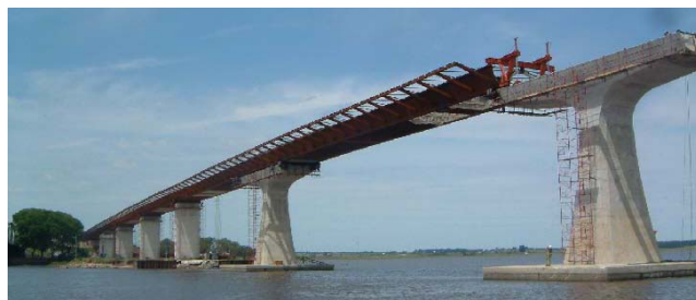
Fig.29: Puente empujado de Santa Lucía en Montevideo (cortesía de MC2))
