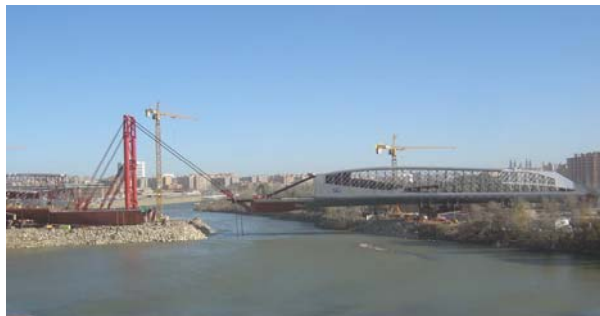
Fig.30 y 31: Lanzamiento del puente de Lanjarón y del Pabellón Puente de ExpoZaragoza 2008 (cortesía de Dragados)
