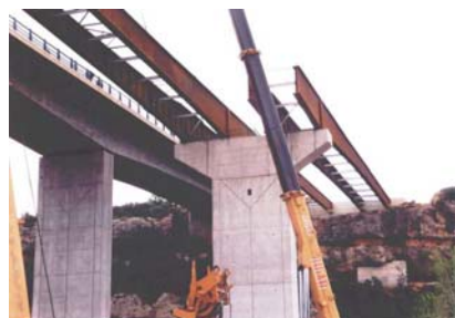
Fig.10 y 11: Viaducto Betxi-Borriol. Montaje de sección doble viga
