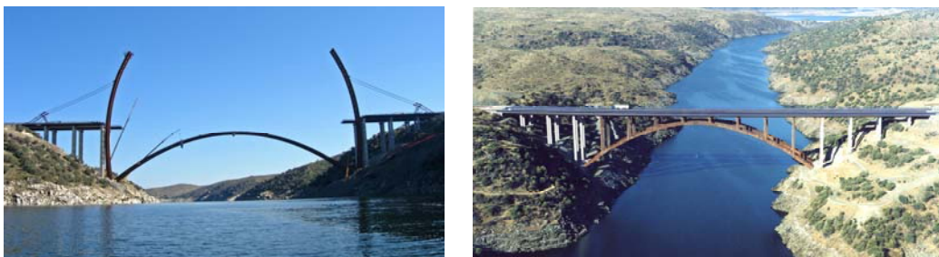
Fig.21 y 22: Puente de Alconetar (cortesía de OHL/Etípsa)
