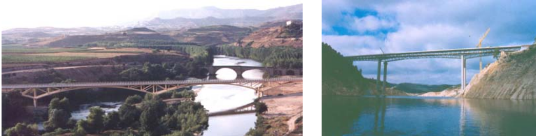
Fig.14 y 15: Puente de San Vicente de la Sonsierra sobre el río Ebro y Puente del Embalse de Contreras (cortesía de MC2/Ideam/Dragados)
