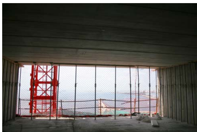
Fig. 16: Vista de prelasas prefabricadas y ferralla superior de losa Fig. 17: Vista de prelasas entre dos pantallas situadas a 9 m
