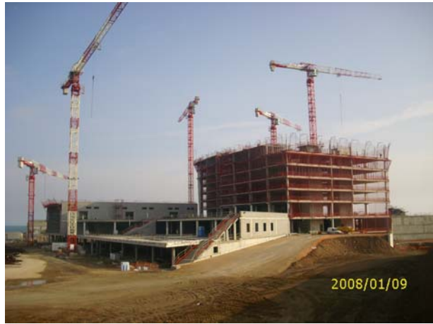
Fig. 12: Vista del Podium de dos plantas y de inicios de Atrio y Torre
