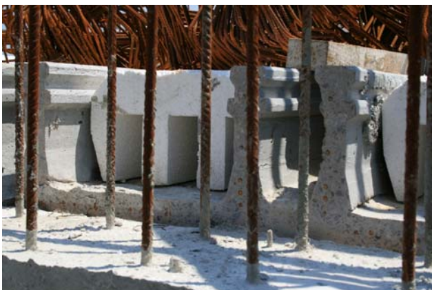
Fig. 15: Vista de prelasas prefabricada pretensada con aligeramiento interior.
