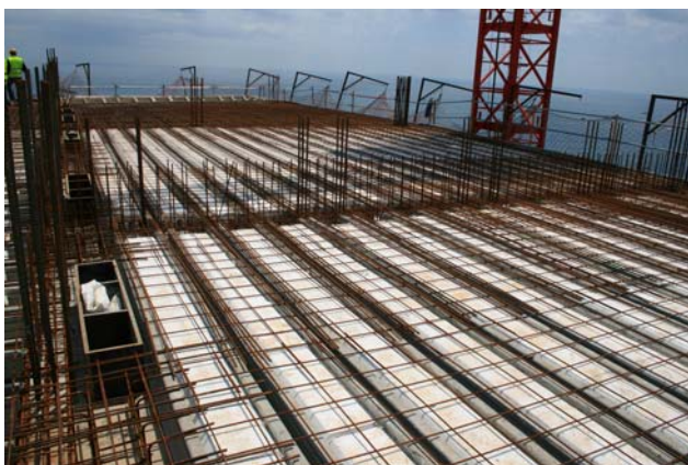
Fig. 16: Vista de prelasas prefabricadas y ferralla superior de losa Fig. 17: Vista de prelasas entre dos pantallas situadas a 9 m
