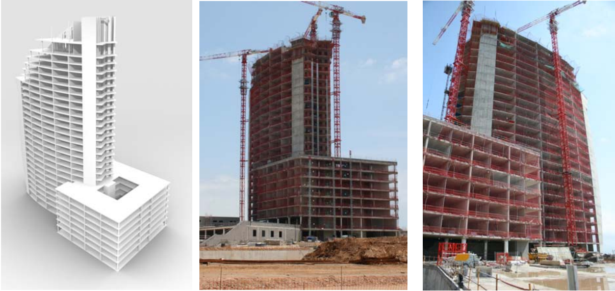
Figs. 4a, 4b y 4c: Esquema de elementos verticales y vistas de la estructura de la Torre y el Atrio durante la ejecución
