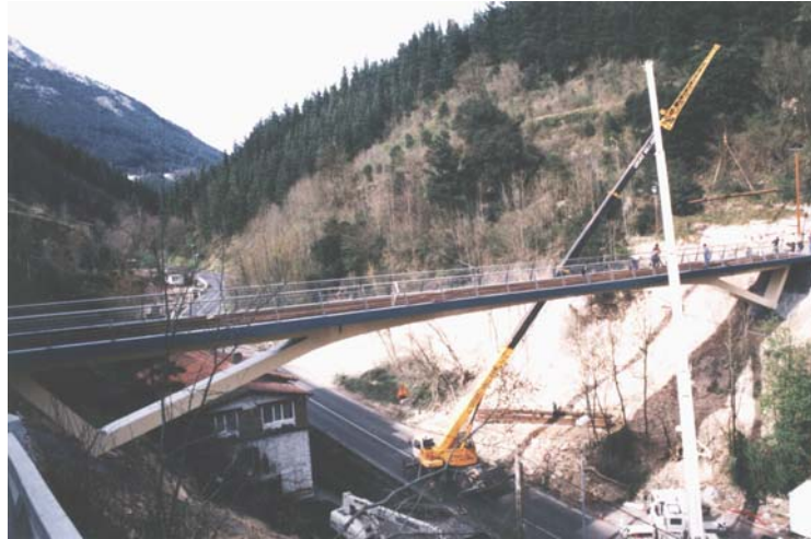
Fig. 8: Imagen frontal de la pasarela concluida durante la prueba de carga.
