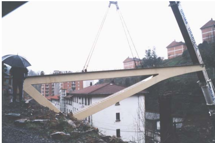
Fig. 6: Imagen del izado de uno de los tramos laterales
