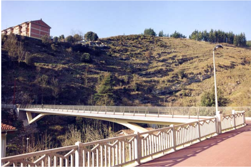
Fig. 1: Imagen de la pasarela concluida.
