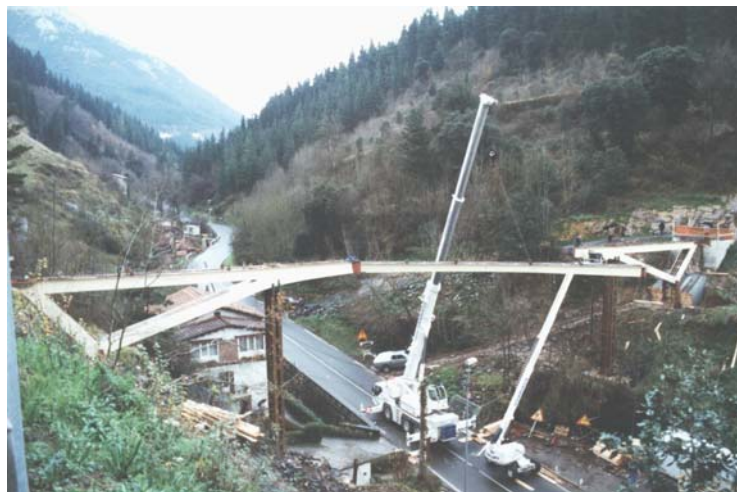
Fig. 7: Imagen del izado del tramo central
