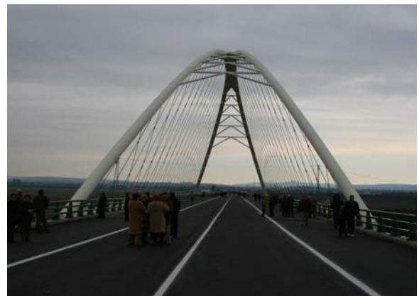
Fig.9 Puente de Palma del Río. Vista transversal (2008)
