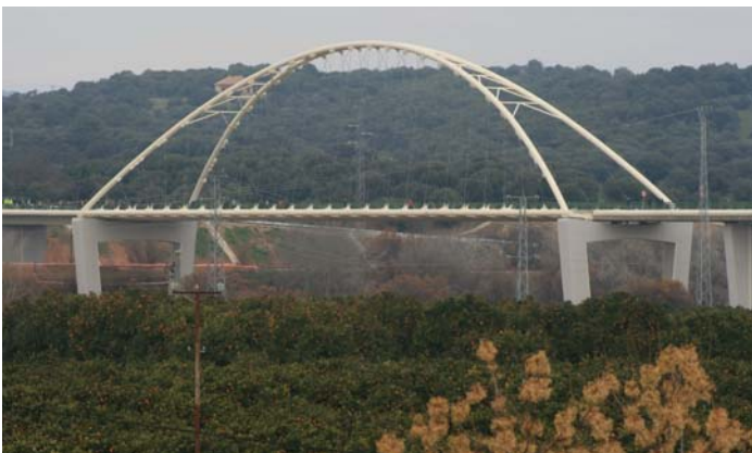
Fig.8 Puente de Palma del Río. Vista frontal (2008)
