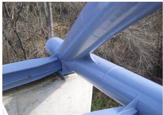
Fig. 20 Pasarela N-VI (60 m). Arranque de arco
