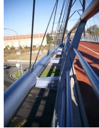
Fig.14 Pasarela sobre la N-II. Detalle lateral
