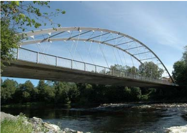
Fig. 1 Puente de Steinkjer (1963)
