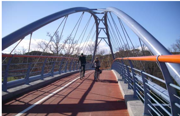
Fig.10 Pasarela sobre la M-500 (52 m). Vista transversal (2007)
