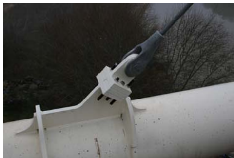
Fig.3 Puente de Palma del Río. Detalle del anclaje de péndola(2008)
