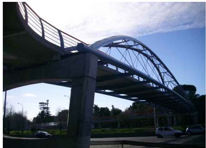
Fig.16 Pasarela sobre la N-VI. Vista inferior
