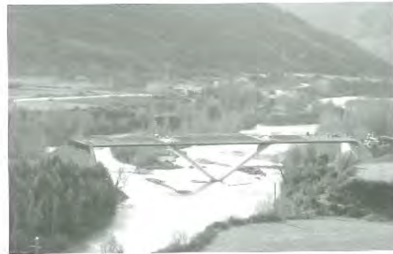
Figura 11. Ejecución de losa
