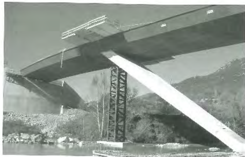
Figura 10: Realización de nudo de unión pila-tablero
