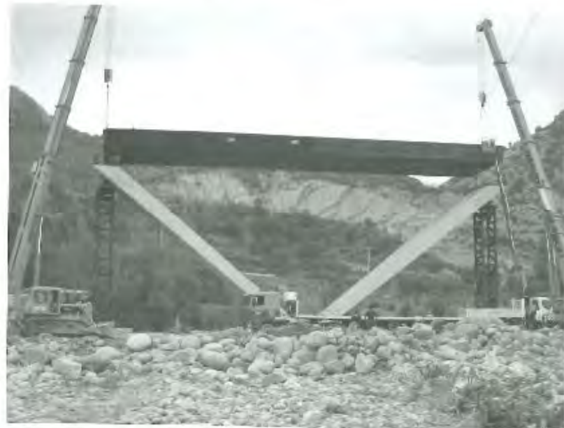
Figura 9. Montaje tramo central
