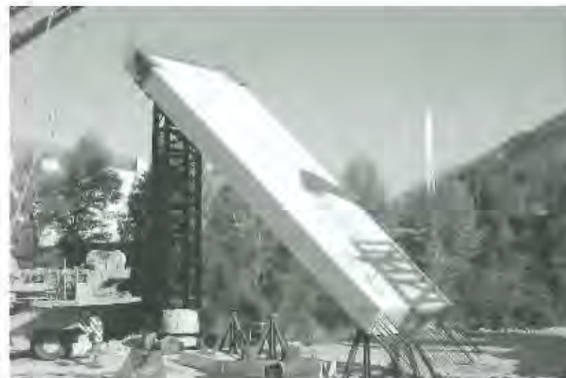
Figura 7. Pila colocada en posición definitiva
