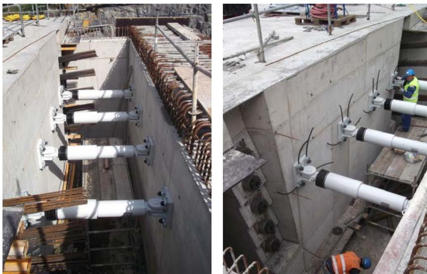
**Figura 9. Transmisores de impacto ‘STU’ en estribo.**
