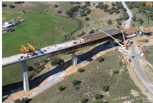
Figura 4. Viaduto de Salobral, LAV Madrid – Valladolid [4]
