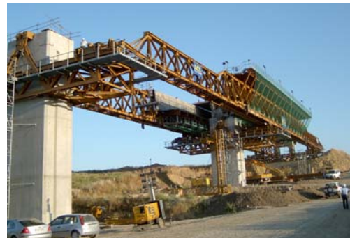
Figura 2. Viaduto sobre o rio Genil na LAV Córdoba-Málaga, constituído por vãos isostáticos de 48,0m e com um comprimento total de 1390m
