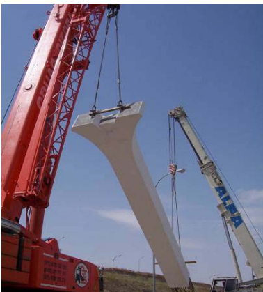
Fig. 3. Montaje de pila prefabricada
