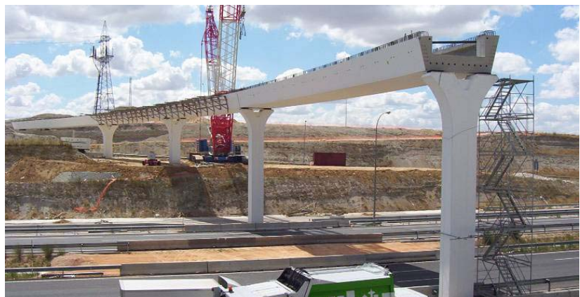
Fig. 4. Vista general con cuatro vigas montadas
