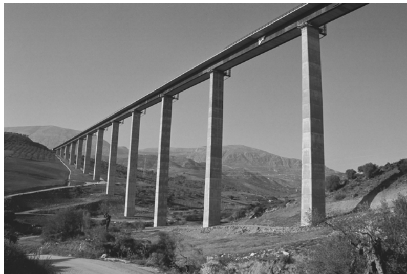
Fig. 1. View of “Arroyo las Piedras” Viaduct.
