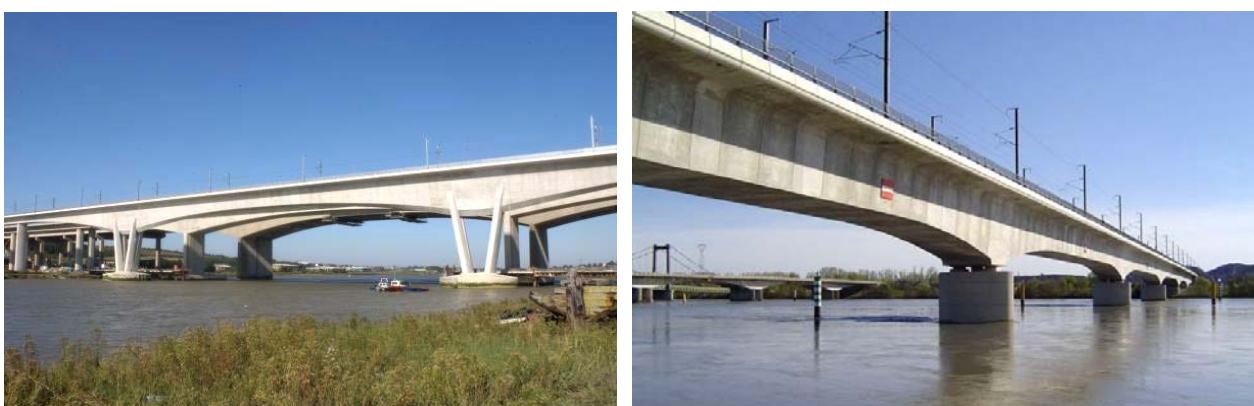
Figura 5. Viaducto de Medway (izda.) y Viaducto de Roquemaure (dcha.)
