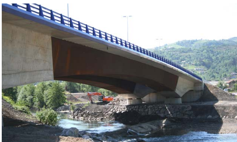
Figura 4. Viaducto de Nalón, 110m de luz sobre el río Nalón, Asturias
