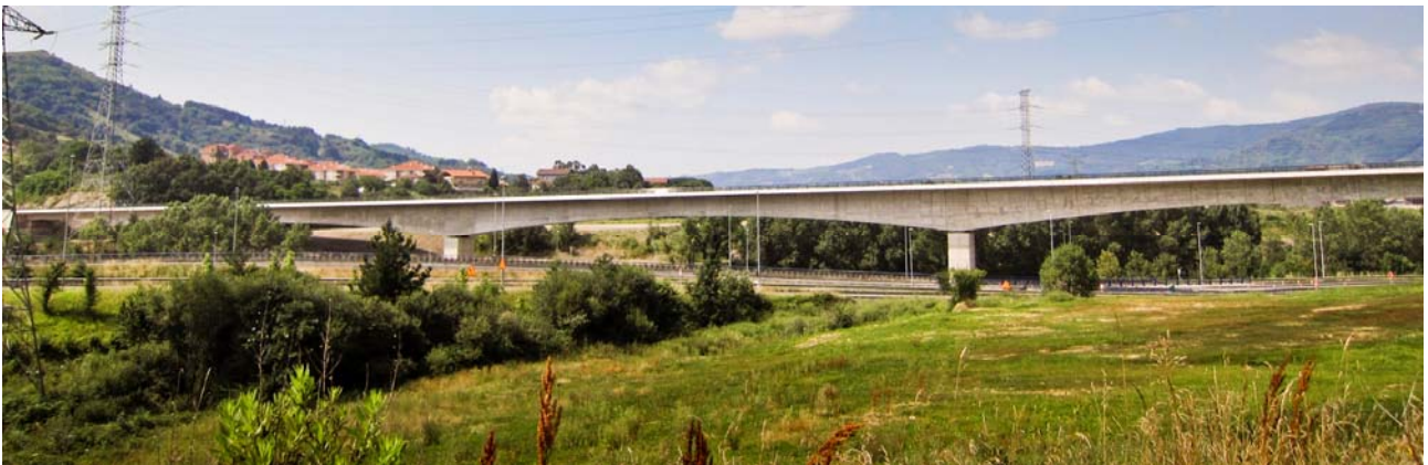
Figura 2. Vista general del Viaducto del río Nervión
