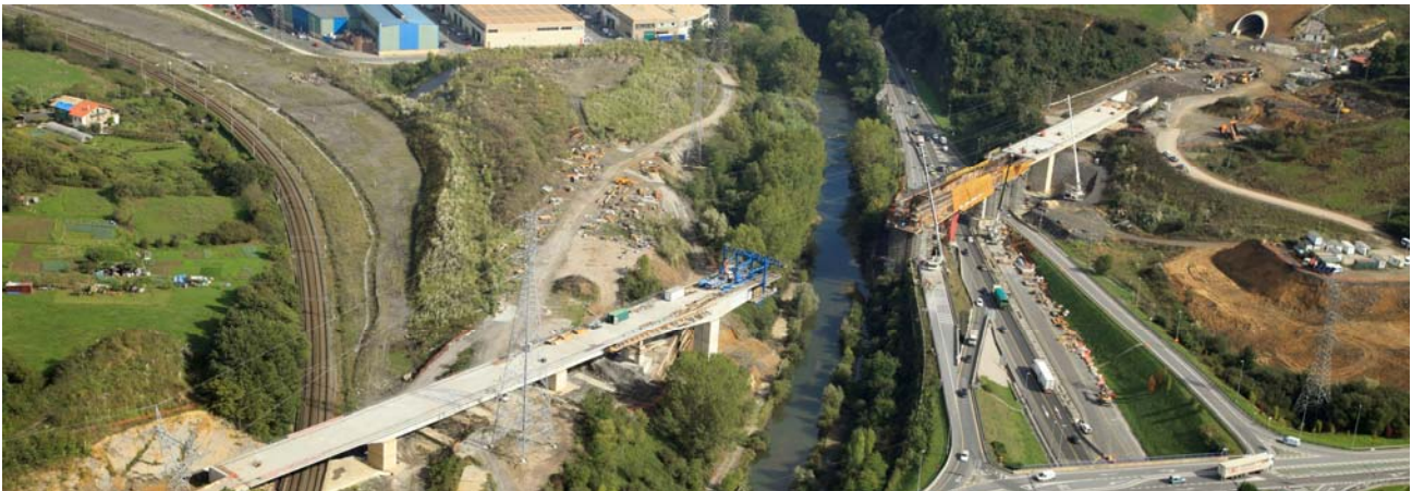
Figura 9. Vista general del Viaducto del río Nervión durante su ejecución.
