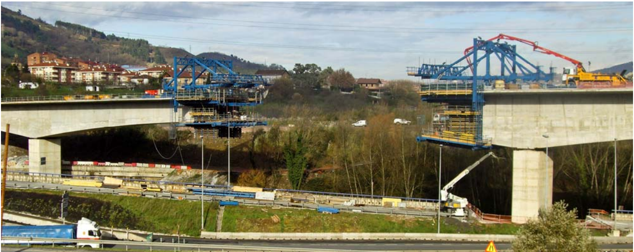
Figura 11. Vista general del vano 3 durante su ejecución mediante avance en voladizo.
