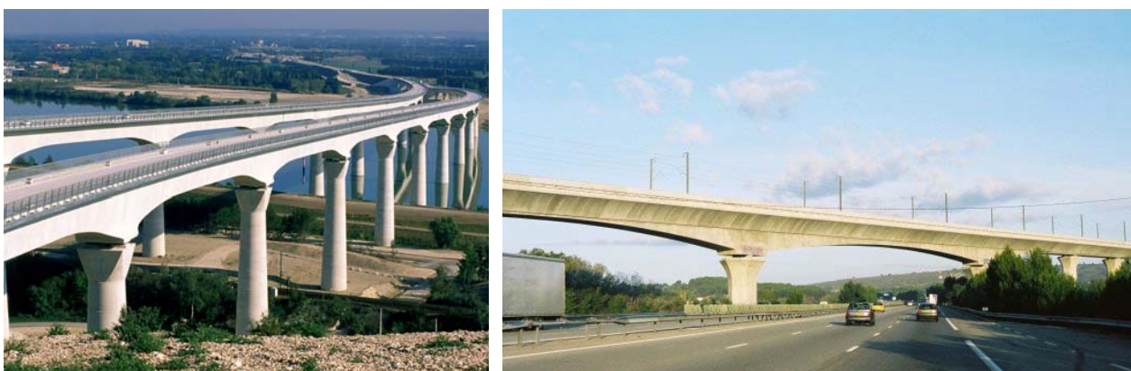
Figura 6. Viaducto de Aviñón (izda.) y Viaducto de Ventabren (dcha.)
