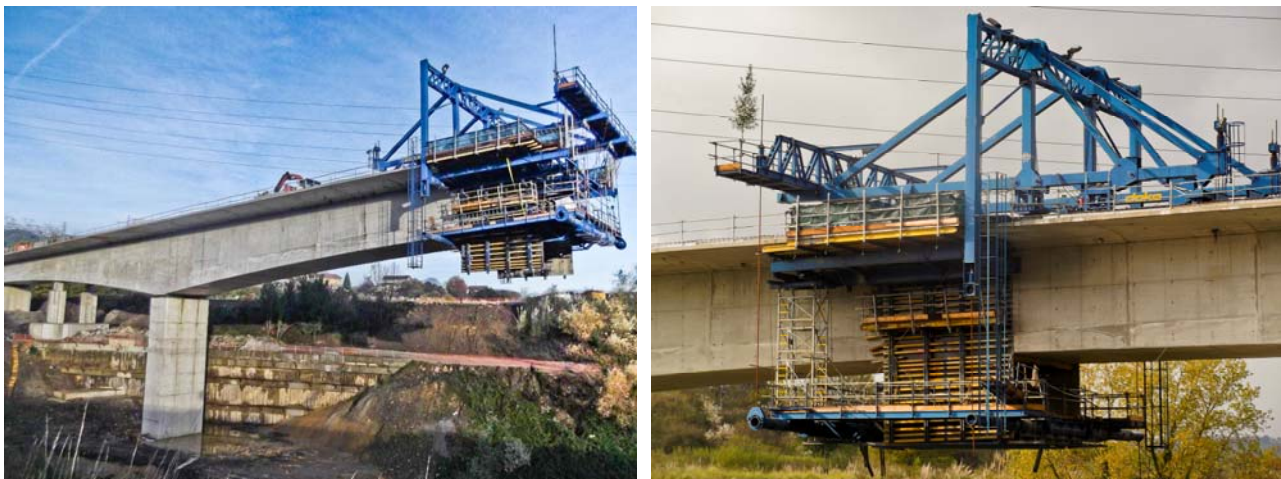
Figura 12. Vista del voladizo de pila P3 (izda.) Vista de la operación de cierre de clave (dcha.)
