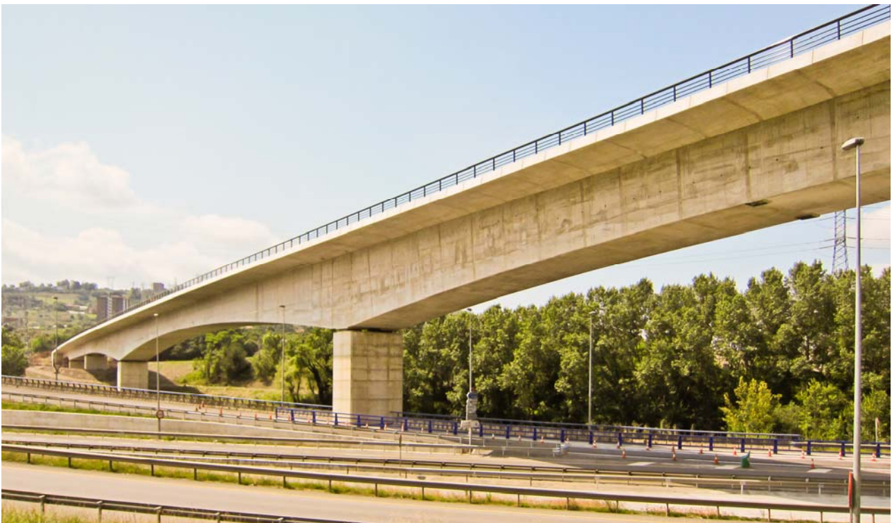
Figura 8. Vista de los vanos 2, de 92m, y 3 de 115 m del Viaducto del río Nervión
