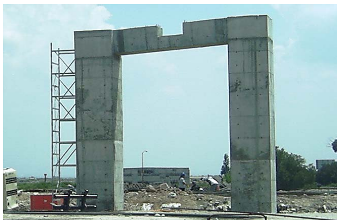
Figura 3. Alzado de pila tipo. (Viaducto “Peñón-Texcoco”)
