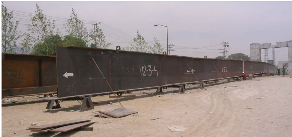
Figura 7. Vigas acopiadas previamente al izado
