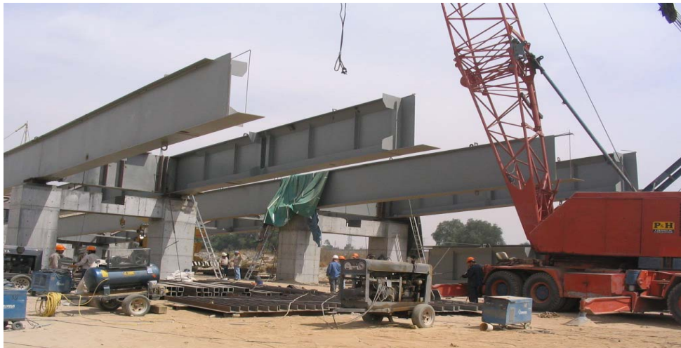
Figura 6. Vigas montadas en viaducto Hank González
