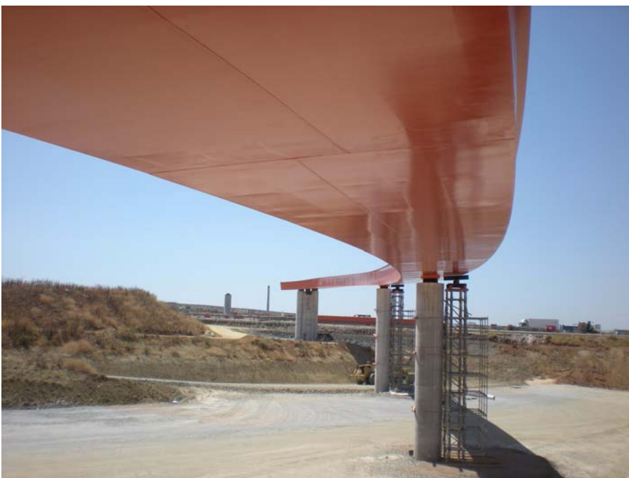
Fig. 9 Vista de la estructura metálica del PS-07 durante su construcción
