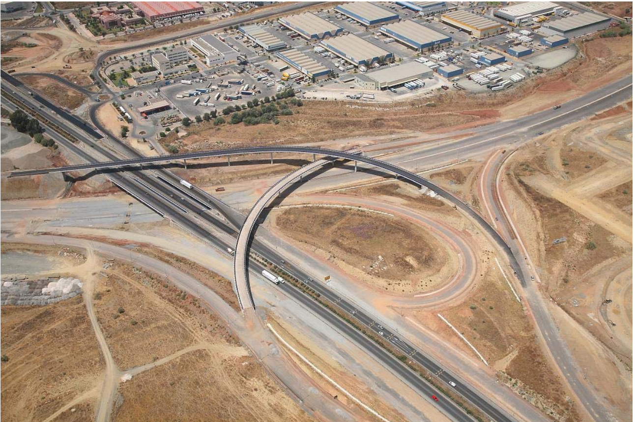
Fig. 1 Vista aérea de los viaductos
