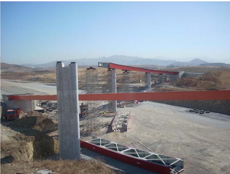
Fig. 7 Vista de la estructura metálica y de las pilas durante la construcción
