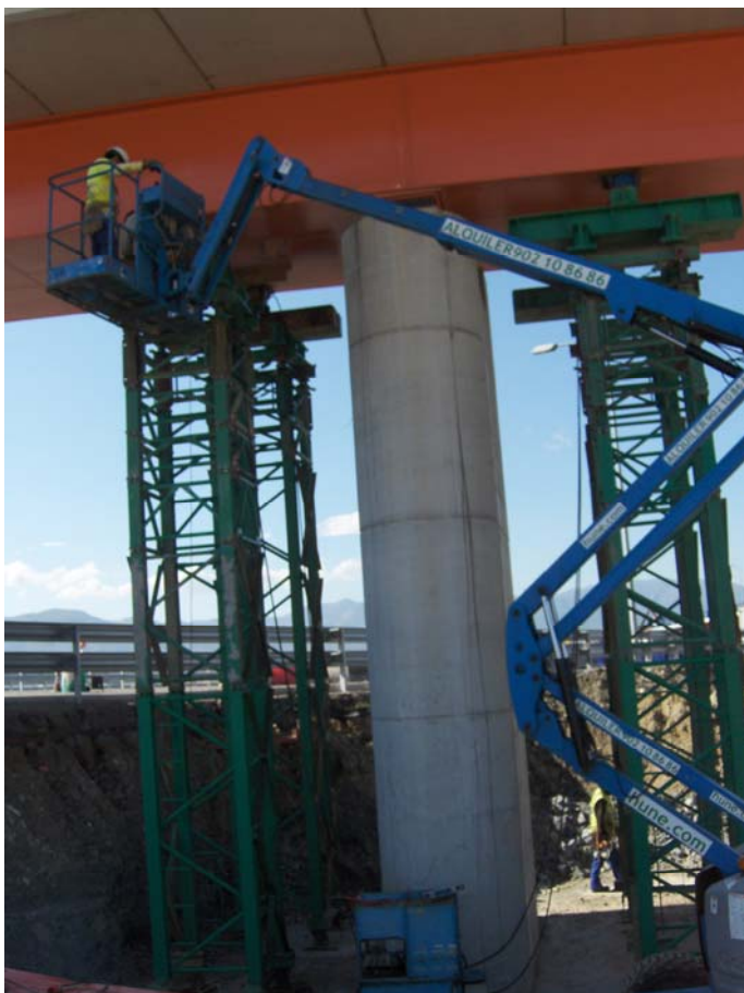
Fig. 10 Castilletes (2 por lado) para contragiro en P4 del PS-07
