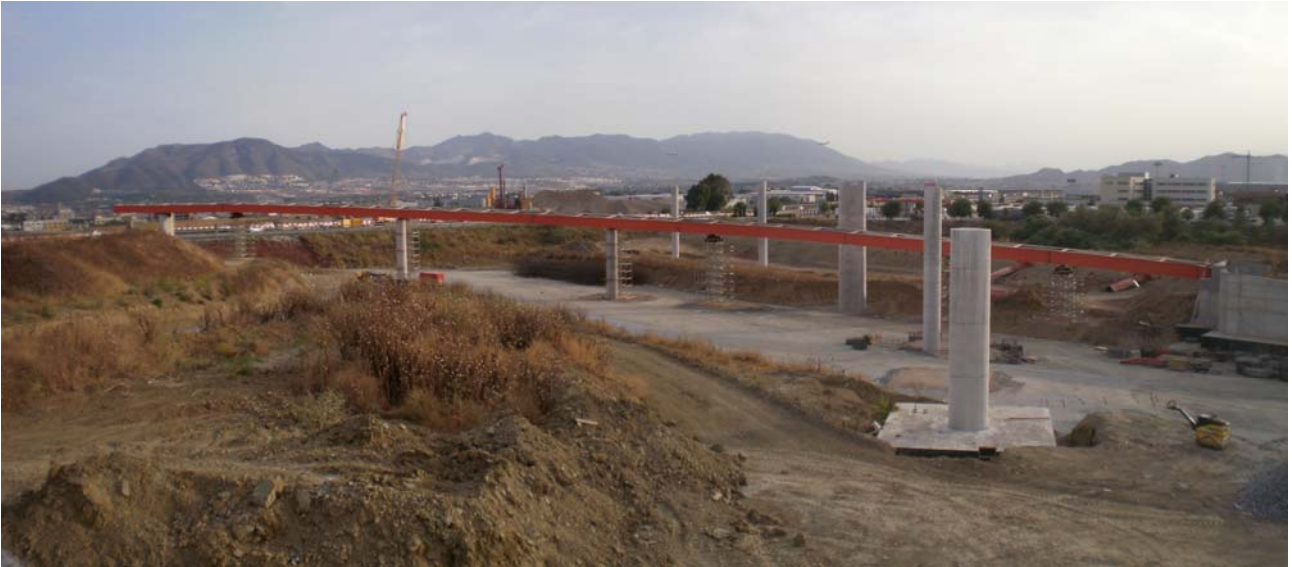
Fig. 6 Vista general del montaje del PS-07
