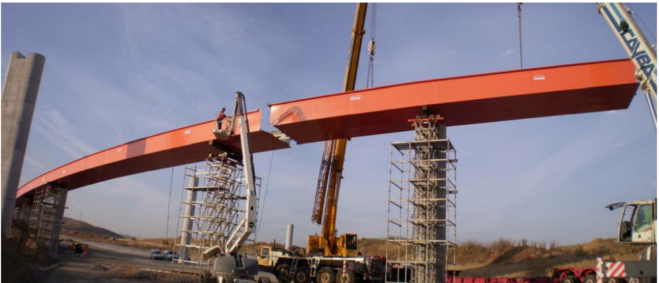
Fig. 8 Vista de la estructura metálica del PS-07 durante su construcción
