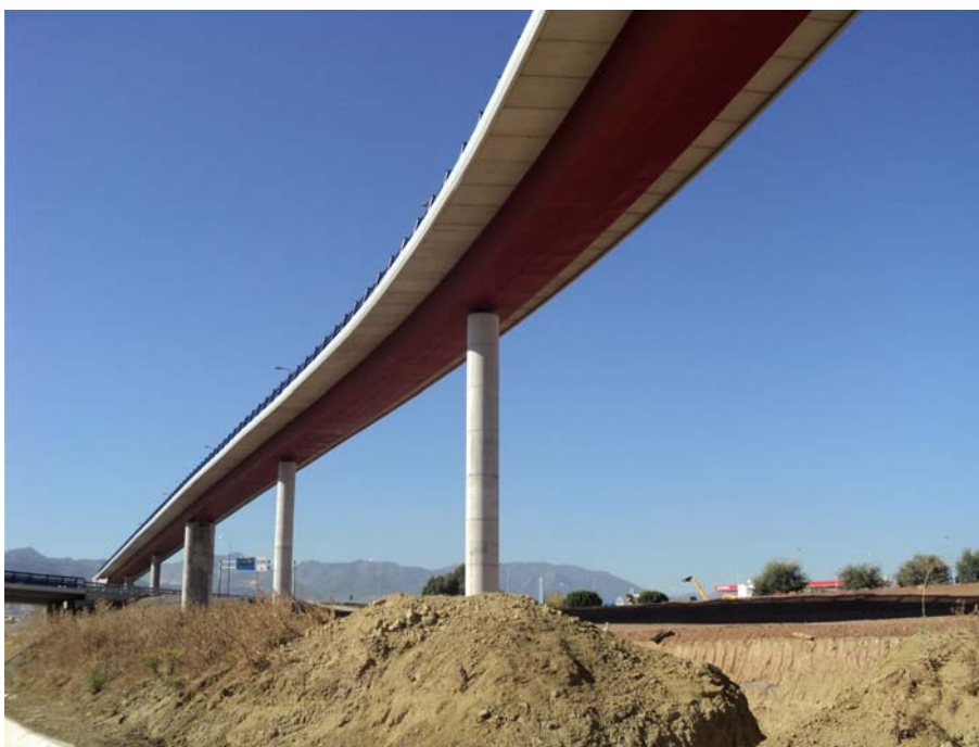
Fig. 5 Vista del fondo de cajón del PS-08 en la zona de clotoide
