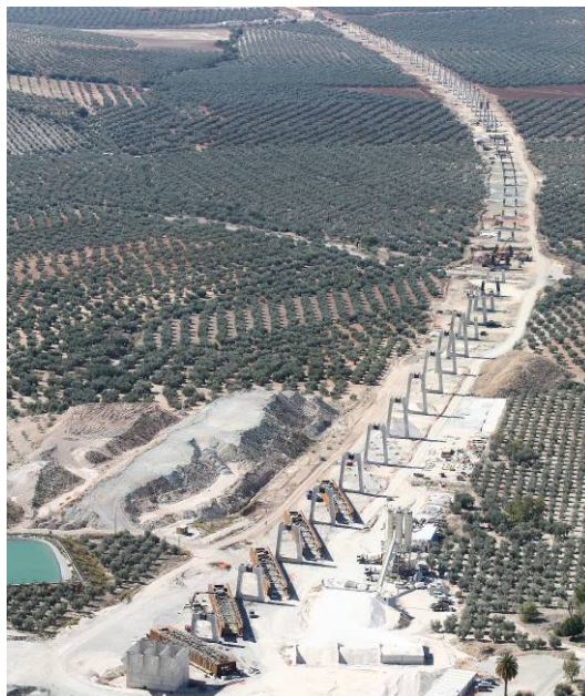
Figura 5. Vista aérea general del Viaducto en construcción.
