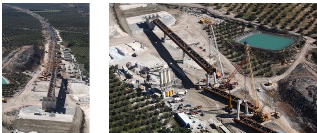
Figura 12. Montaje de las dovelas metálicas del viaducto.
