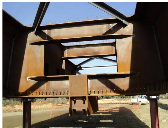
Figura 9. Vista del sistema de tope fijo en cabeza de pila y en mamparo de dovela metálica.
