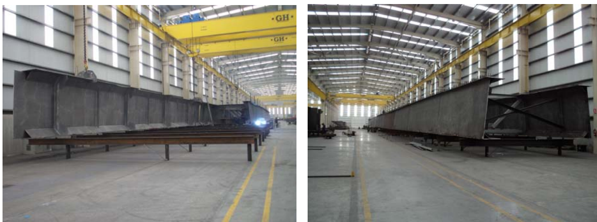
Foto 11. Fabricación de dovelas en taller.
