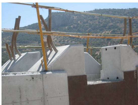
Figura 9. Vista del sistema de tope fijo en cabeza de pila y en mamparo de dovela metálica.
