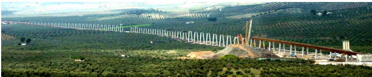
Figura 10. Vista general del viaducto durante su ejecución.
