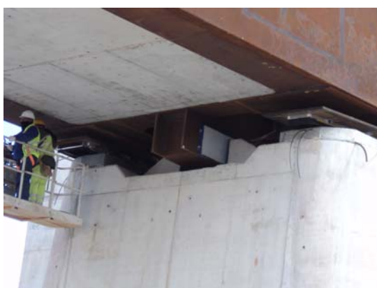
Figura 13. Vista inferior del tope sísmico y aparatos de apoyo en estribo
