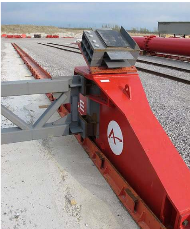
Figura 4. Skidshoe en parque de empuje, con medios de ajuste de cota
