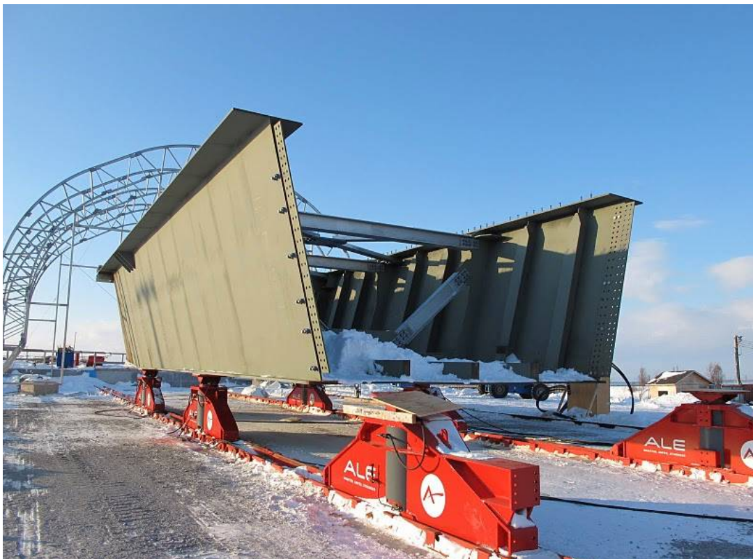
Figura 2. Vista de un tramo de sección metálica del cajón
