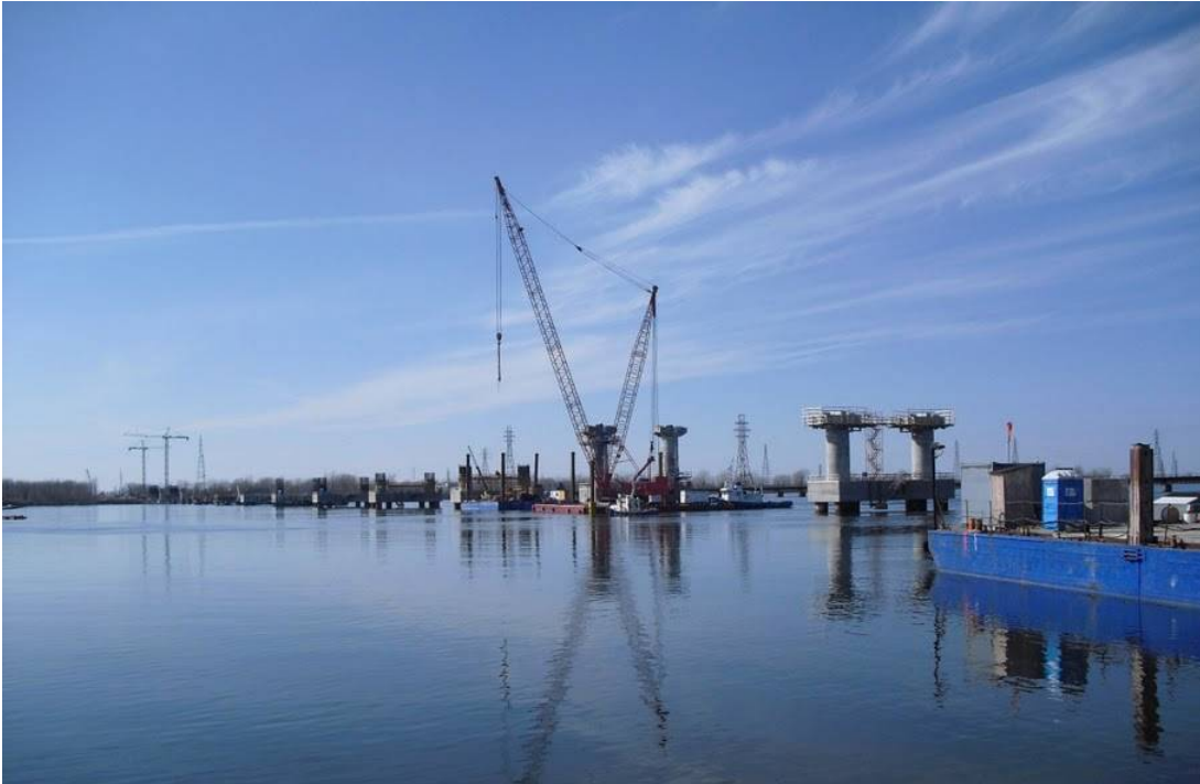
Figura 6. Canal de Beauharnois. Construcción de pilas
