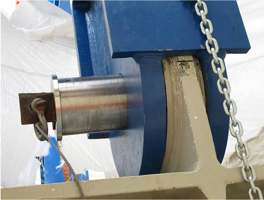
Figura 9. Detalle de conexión bulonada nariz-tablero
