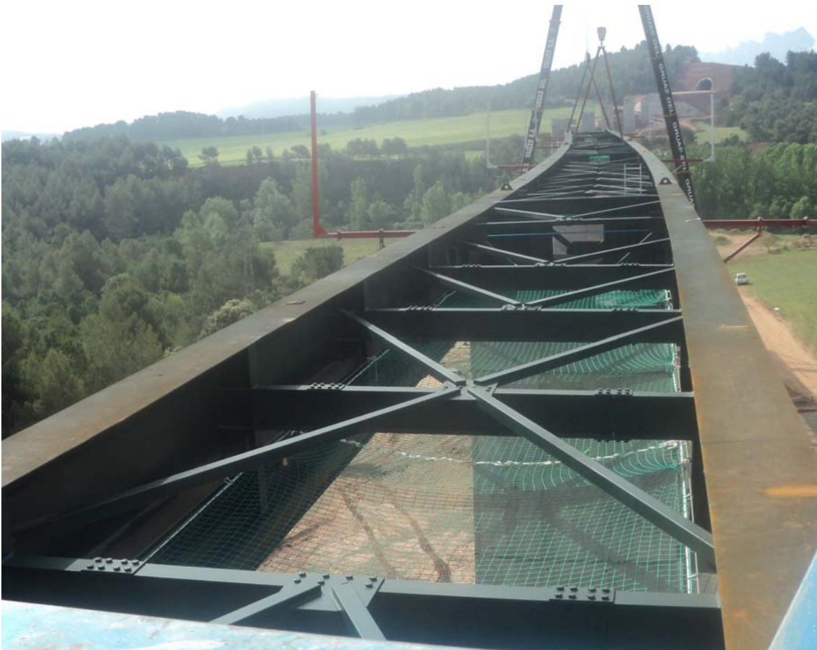
Fig. 5 Vista de los arriostramientos superiores
