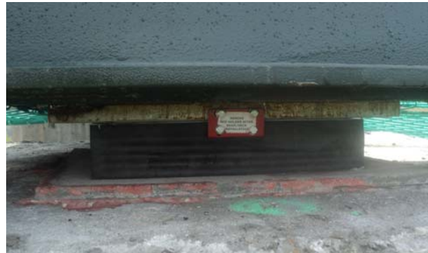
Fig. 7 Detalle de apoyo neopreno teflón y fijación provisional en estribos
