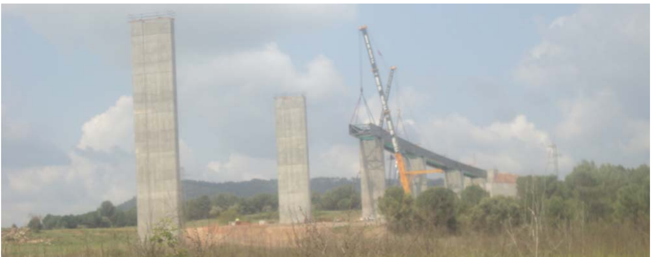
Fig. 2 Vista general del viaducto
