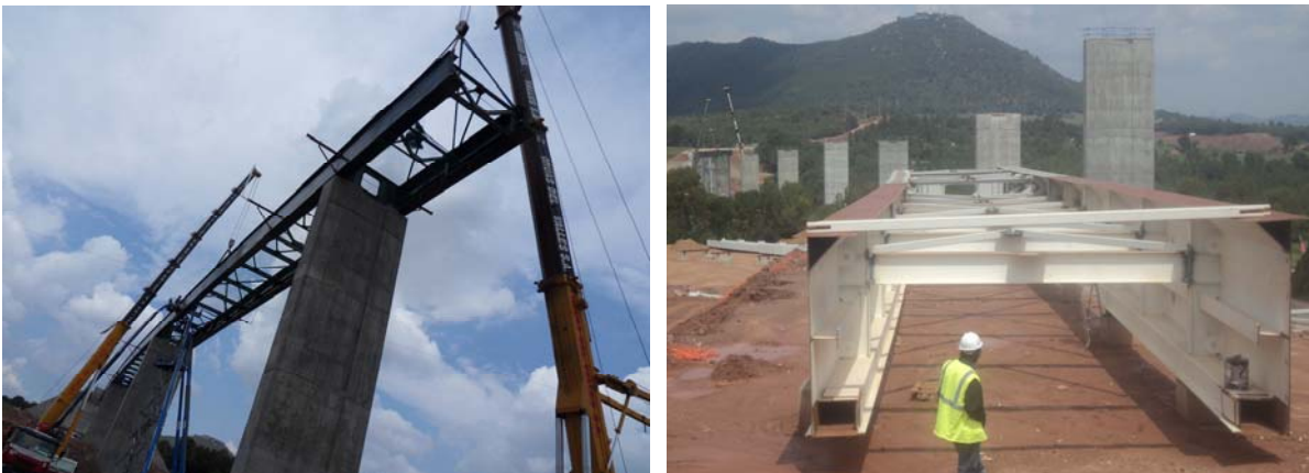
Fig. 7 Montaje del vano 10 y preparación de los vanos 1 a 3
