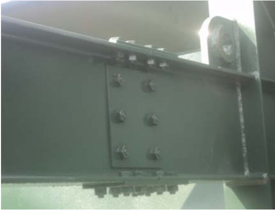
Fig. 4 Detalle de marco atornillado y de solución soldadas de una pieza
