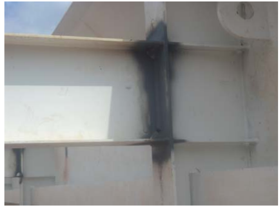
Fig. 4 Detalle de marco atornillado y de solución soldadas de una pieza
