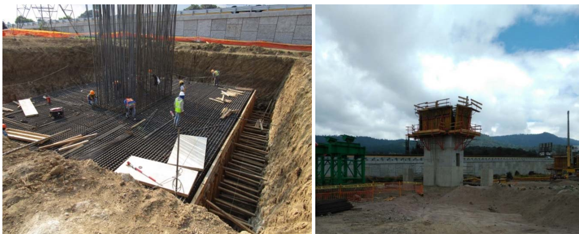
Figura 12a y 12b. Ferrallado de cimentación y alzado de pila
