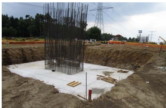
Figura 8. Ejecución de una cimentación del Viaducto 2
