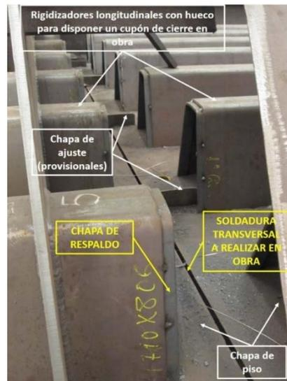
**Figura 11** Empalme con cupón de rigidizadores longitudinales en el cruce de una soldadura transversal de obra en la chapa de piso
