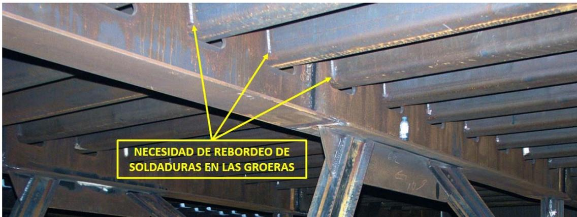
**Figura 8** *Detalle 1 de tabla 8.8 de UNE-EN 1993-1-9 [2]. Cruce del rigidizador longitudinal con soldadura en ángulo rebordeada en el extremo de la groera*
