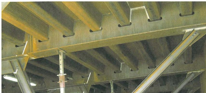
**Figura 6** Cruce de rigidizadores longitudinales con groeras en la parte inferior de los rigidizadores transversales. Detalle 1 de tabla 8.8 de UNE-EN 1993-1-9 [2]
