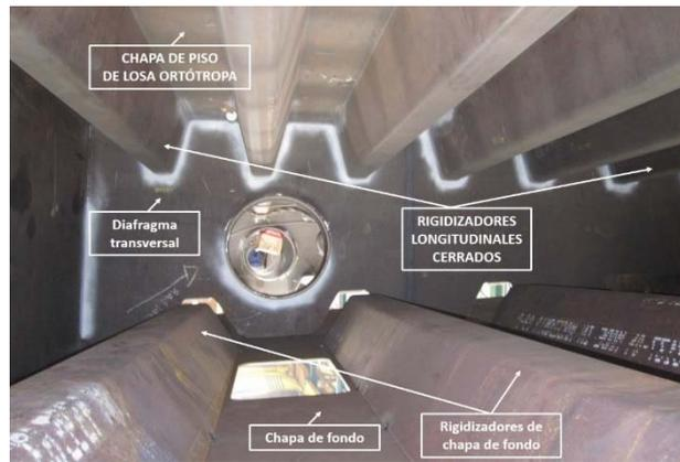
**Figura 1** Vista de una losa ortótropa con rigidizadores longitudinales cerrados
