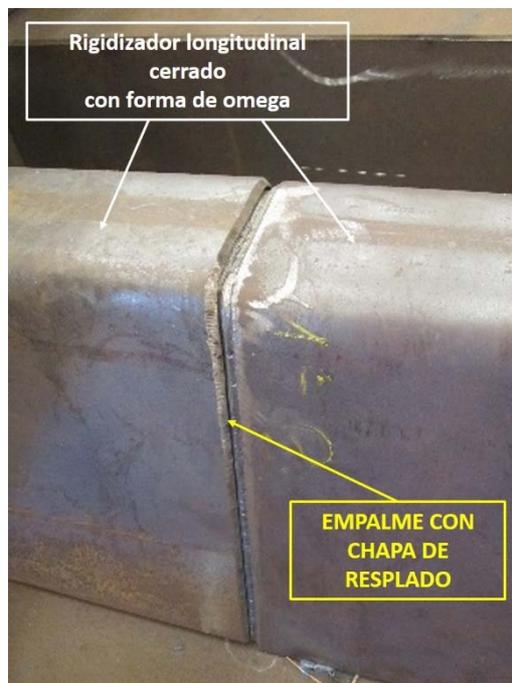
**Figura 10** Empalmes de rigidizador longitudinal con chapas de respaldo (imagen del rigidizador en posición invertida en taller)
