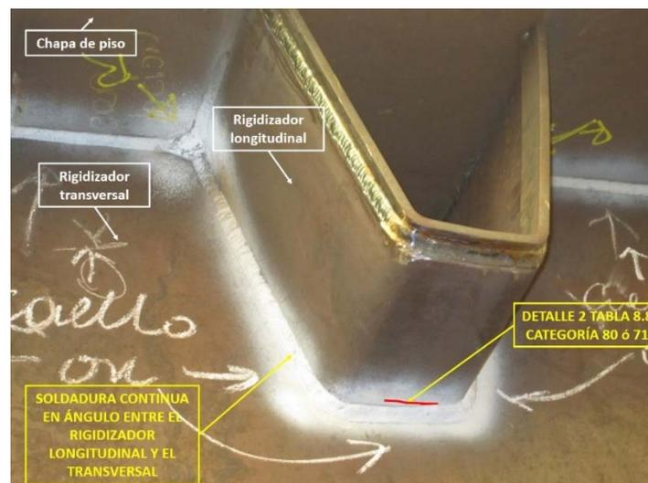
**Figura 9** *Detalle 2 de tabla 8.8 de UNE-EN 1993-1-9 [2]. Cruce del rigidizador longitudinal con soldadura en ángulo continua con el rigidizador transversal*
