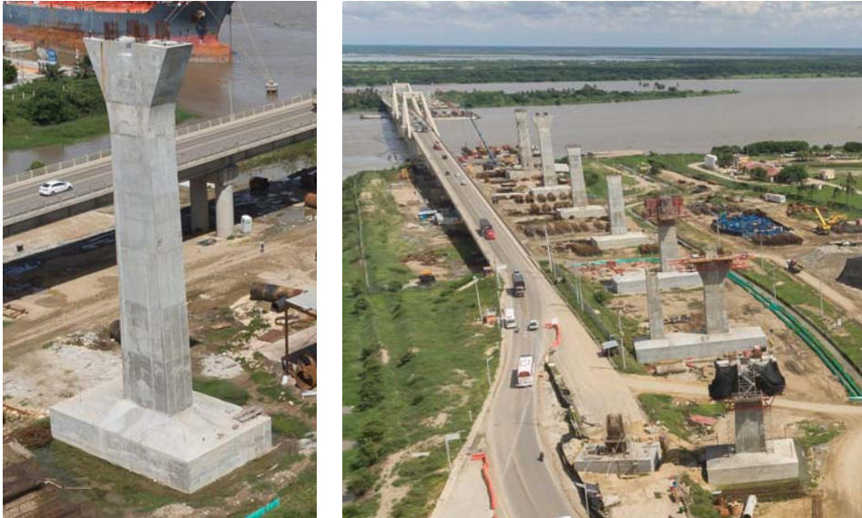
Figura 11. Alzado de fuste y capitel de las pilas de los vanos de acceso. Fustes pilas ejecutadas.
