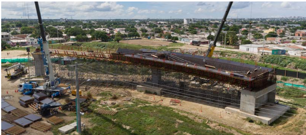
Figura 6. Vano del ramal Puerto-Santa Marta en construcción
