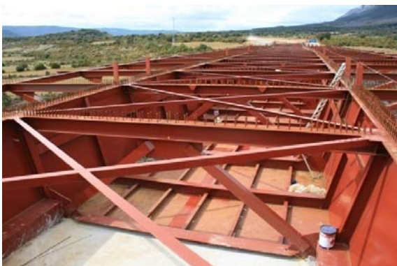
Figuras 6a y 6b. Vista del interior del cajón metálico en zona de positivos y de negativos
