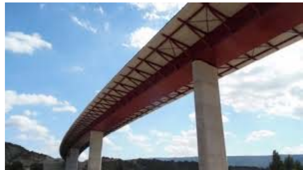
Figuras 5a y 5b. Vista del ancho de la plataforma y cajón metálico con jabalcones laterales
