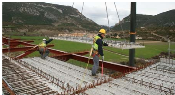
Figura 14. Colocación de prelosas en celosía sobre el tablero metálico
