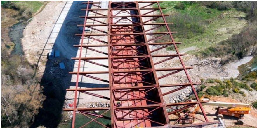
Figura 9. Vista del arriostramiento superior del cajón metálico
