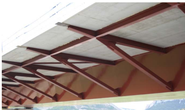
Figura 8. Vista de los jabalcónes laterales
