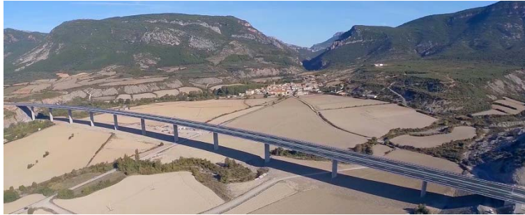
Figura 1. Viaducto de Sigüés en el valle del río Esca sobre la zona que quedará anegada por la ampliación del embalse de Yesa
