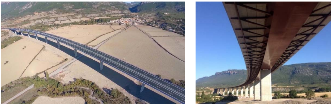
Figuras 16a y 16b. Vista general del viaducto concluido
