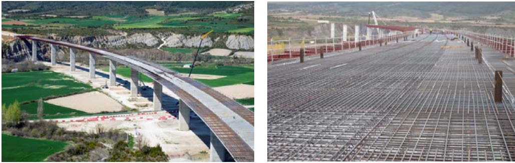
Figuras 15a y 15b. Montaje de prelasas y hormigonado de la zona central del tablero.
