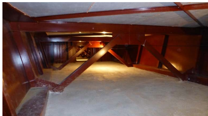
Figuras 6a y 6b. Vista del interior del cajón metálico en zona de positivos y de negativos
