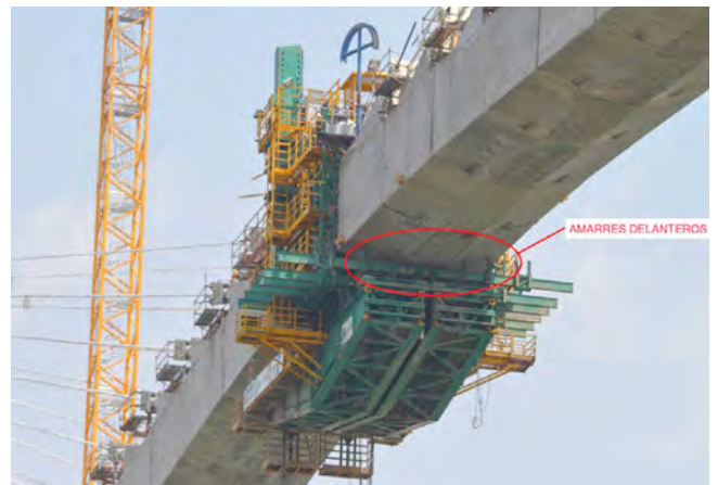
Figura 13. Detalle de carro norte en el segmento de cierre del arco visto desde el lado sur.
