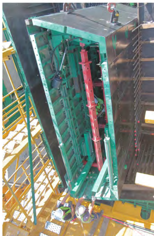
Figura 16. Detalle de paneles de encofrado interior.
