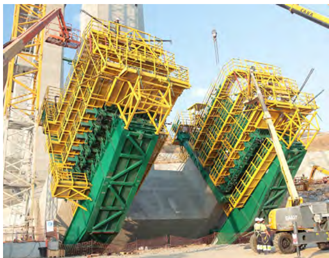
Figura 2. Carros de encofrado montados sobre el arranque.
