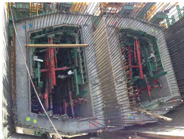
Figura 15. Detalle de paneles de encofrado interior.
