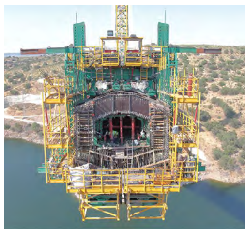
Figura 15. Detalle de paneles de encofrado interior.
