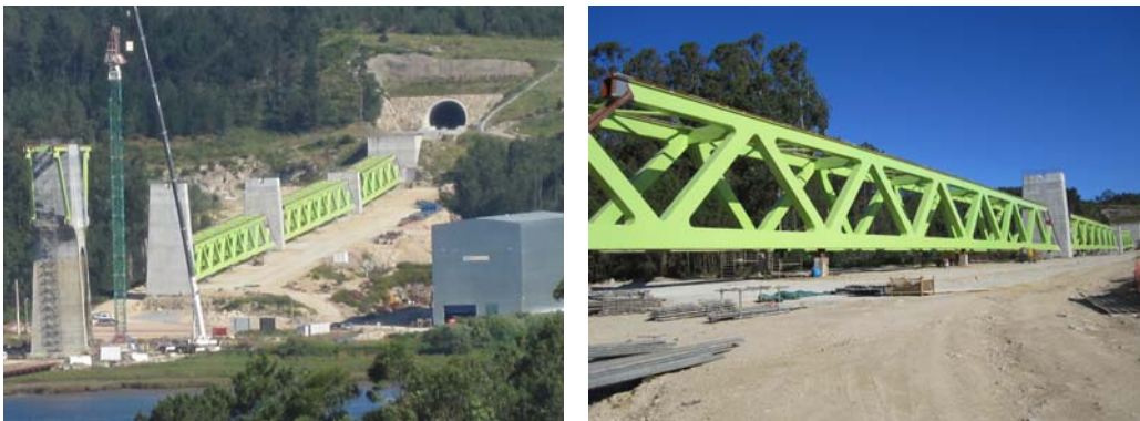
Figuras 8a y 8b. Secuencia del proceso de izado de los vanos laterales 10, 11 y 12.
