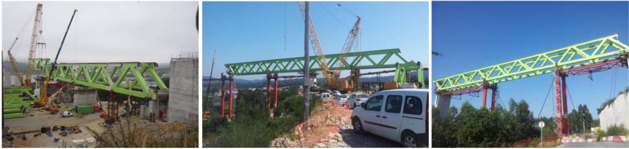
Figuras 5a, 5b y 5c. Izado de dovelas, imagen del primer lanzamiento y tramo lanzado entre P-2 y P-3
