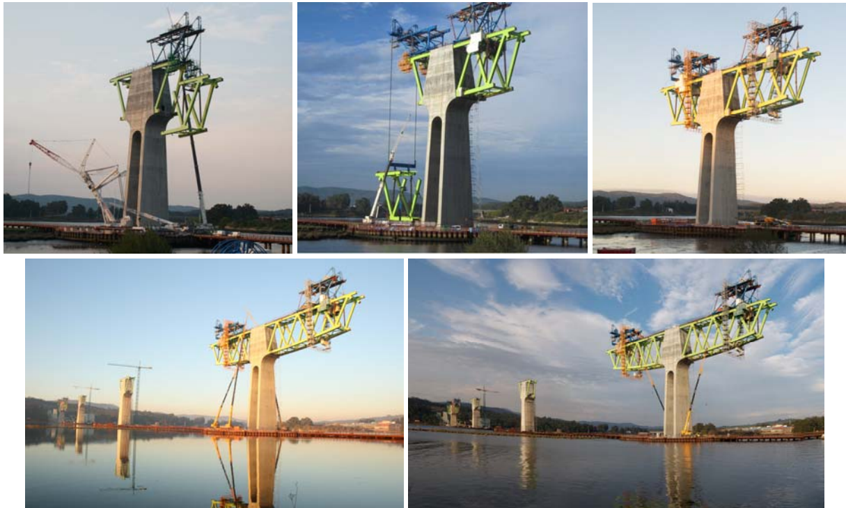
Figura 10. Diferentes vistas del avance por voladizos sucesivos compensados. Pila 5 en primer plano
