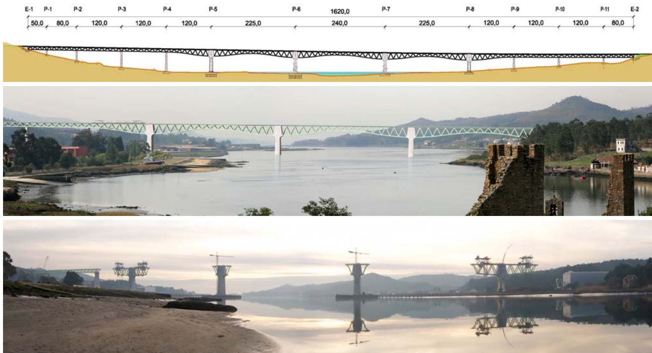
Figuras 1a, 1b y 1c. Alzado, fotomontaje y estado actual del Viaducto sobre el río Ulla (dic. 2013)
