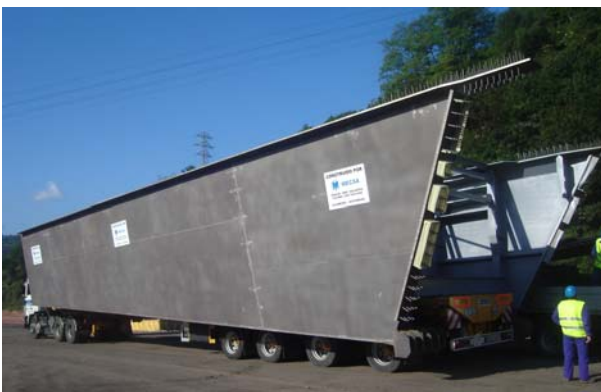
Fig. 8: Transporte del primer tramo metálico.
