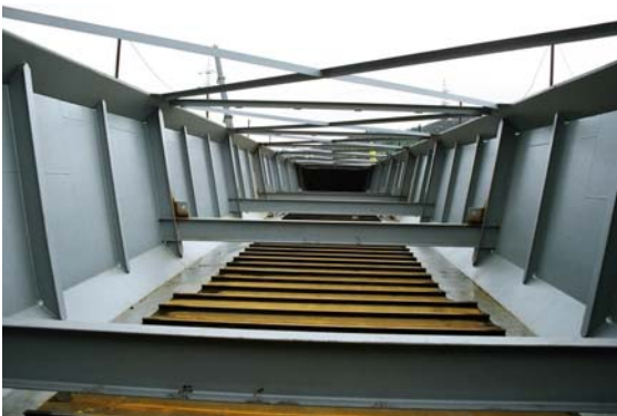
Fig. 11: Vista interior del centro de vano.
