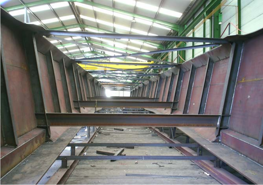
Fig. 3: Vista interior de la sección metálica en taller.
