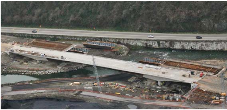
Fig. 13: Vista del segundo en fase de ejecución.
