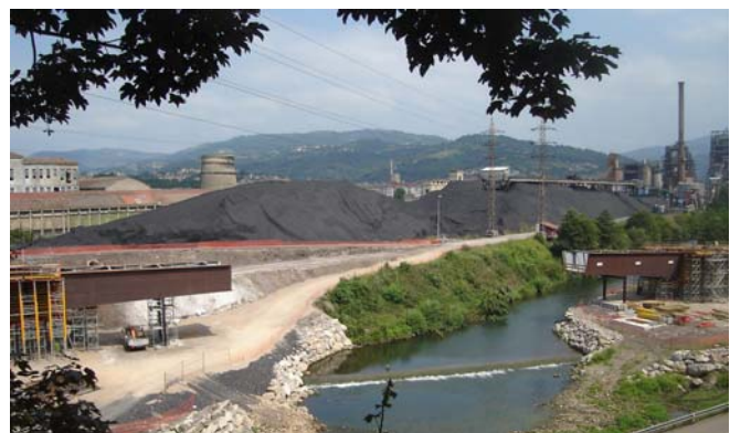
Fig. 9: Vista de los 2 tramos laterales apeados.
