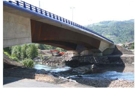
Fig. 14: Vistas de los viaductos concluidos.
