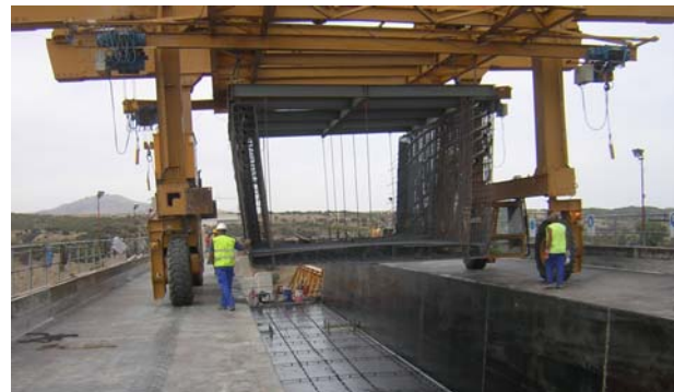
Figs. 4a y 4b Vista del Viaducto del Salobral en construcción con la autocimbra y el carro elefante
