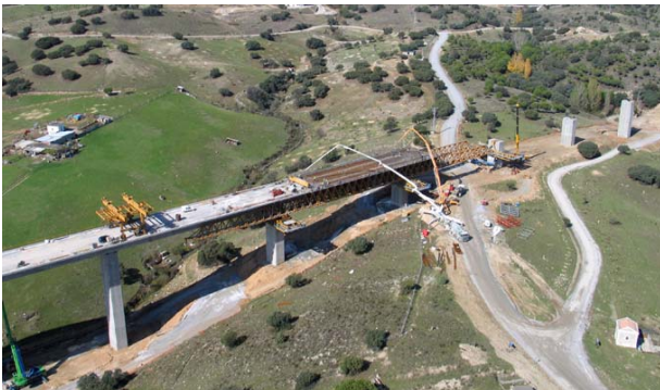
Figs. 4a y 4b Vista del Viaducto del Salobral en construcción con la autocimbra y el carro elefante
