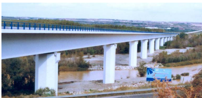
Fig. 1 Vista del puente sobre el río Cinca
