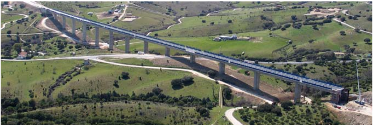
Fig. 3 Vista general del Viaducto del Salobral
