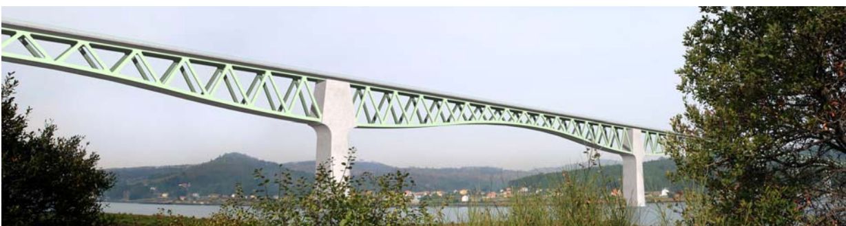
Fig. 8 Vista lateral del vano principal del Viaducto sobre el río Ulla
