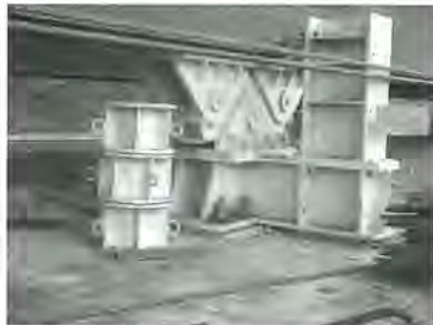
Figura 3. Tablero en parque de empuje Figura 4. Detalle apoyos deslizantes del empuje
