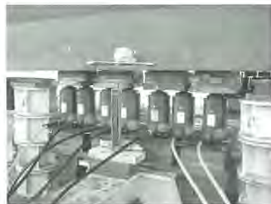
Figura 6. Aplicación reacción localizada con gatos
