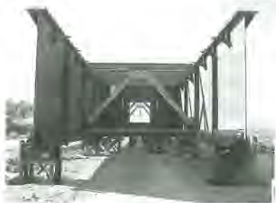
Figura 3. Tablero en parque de empuje Figura 4. Detalle apoyos deslizantes del empuje
