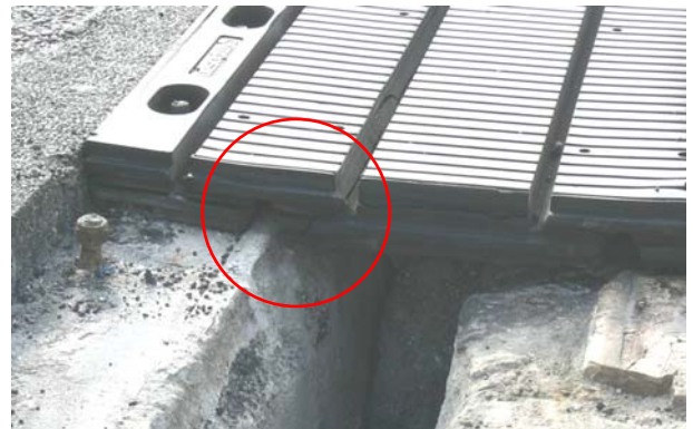
Figs. 11a y 11b: Junta de dilatación colocada descentrada por murete de guarda estricto. Debido al acortamiento de la estructura, el tramo central de la junta se queda apoyado únicamente en un lateral, produciendo inmediatamente la rotura del y el agotamiento de la junta.
