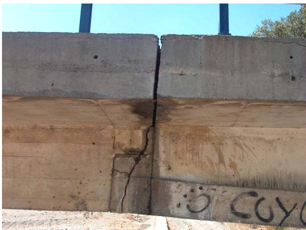
Figs. 9a y 9b: Rotura de apoyo a media madera (izquierda) y degradación del hormigón (derecha) en ménsulas cortas de media madera por presencia cuasicontinua de agua, debido a la deficiente conservación de las juntas de calzada y al poco espacio existente para la evacuación del agua. Zonas de difícil disposición de la armadura por su densidad y reducidas dimensiones del elemento.
