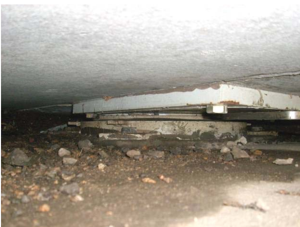
Figs. 8a y 8b: Agotamiento de carrera de bandeja de apoyo tipo POT (izquierda) y rotura de lámina de acero inoxidable en guía por el bloqueo producido por la colocación de dos apoyos guiados sobre la misma pila.
