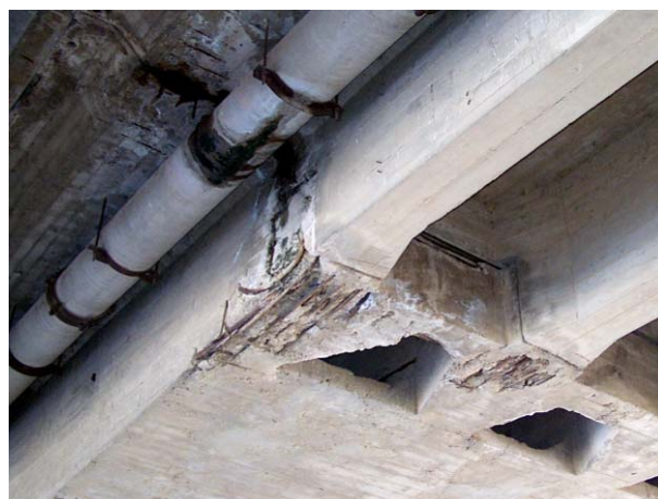
Figs. 9a y 9b: Rotura de apoyo a media madera (izquierda) y degradación del hormigón (derecha) en ménsulas cortas de media madera por presencia cuasicontinua de agua, debido a la deficiente conservación de las juntas de calzada y al poco espacio existente para la evacuación del agua. Zonas de difícil disposición de la armadura por su densidad y reducidas dimensiones del elemento.
