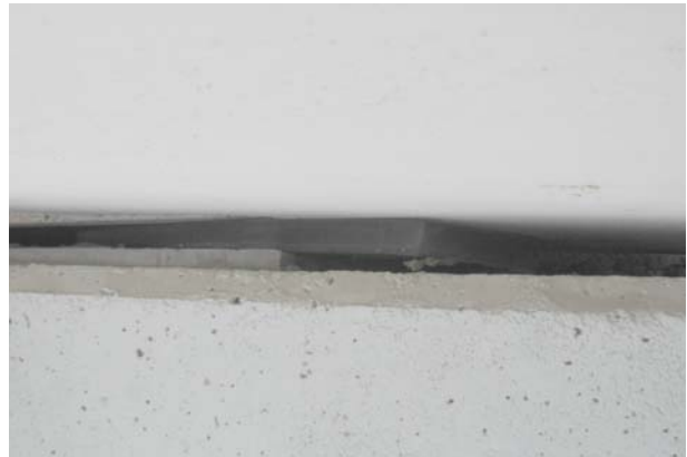
Figs. 5a y 5b: Deficiente puesta en obra de los aparatos de apoyo, con importantes errores de replanteo, nivelación y paralelismo entre las caras de apoyo, habiendo producido la reptación y expulsión de los aparatos de apoyo.
