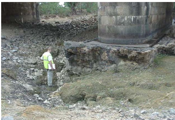
Figs. 2a y 2b: A la izquierda, fosa de socavación en un puente arco de fábrica. A la derecha, cimentación de pila afectada por la erosión general y local, en un puente arco de hormigón.
