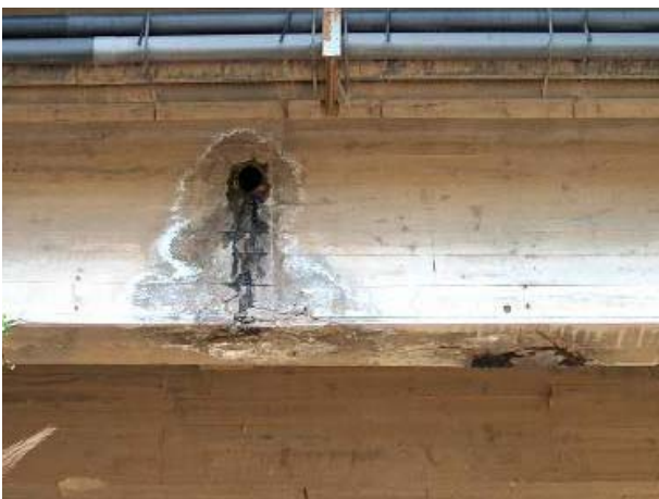
Figs. 13a y 13b: Daños en vigas de hormigón por la presencia de un imbornal en sus proximidades carente de bajante y elementos de desagüe adecuados.
