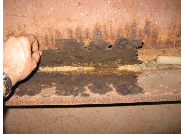
Figs. 14a y 14b: Interior de un cajón mixto de acero corten con importantes filtraciones de agua, habiendo degenerado en el deterioro del sistema de pintura y la oxidación del acero corten, al no ser capaz éste de generar la capa de pátina debido a la falta de ventilación, la alta humedad interior y la condensación interior.
