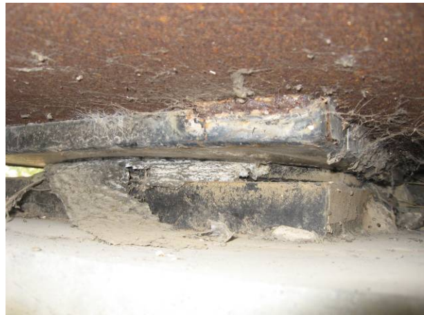
Figs. 7a y 7b: Rebasamiento de la lámina de teflón (PTFE) del apoyo tipo POT (izquierda). Rasgado y expulsión de la lámina de teflón (derecha). En ambos casos, el coeficiente de rozamiento menor del 5% no se puede garantizar, suponiendo un mayor bloqueo del esperado en Proyecto, pudiendo causar daños en pilas y estribos, así como en sus cimentaciones.
