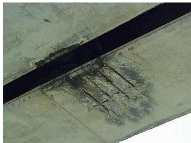
Figs. 13a y 13b: Daños en vigas de hormigón por la presencia de un imbornal en sus proximidades carente de bajante y elementos de desagüe adecuados.
