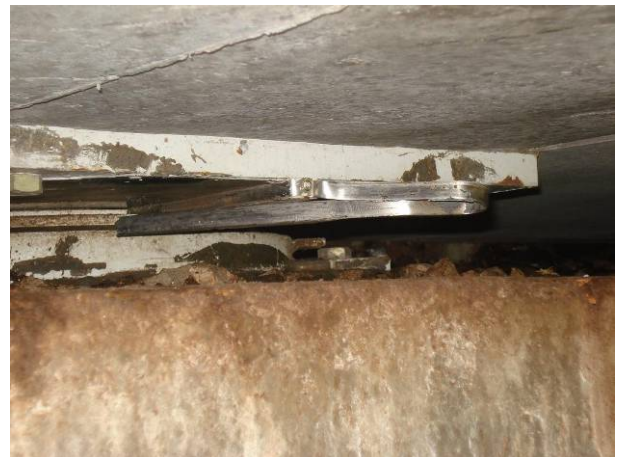
Figs. 8a y 8b: Agotamiento de carrera de bandeja de apoyo tipo POT (izquierda) y rotura de lámina de acero inoxidable en guía por el bloqueo producido por la colocación de dos apoyos guiados sobre la misma pila.
