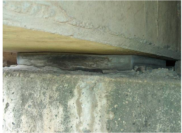
Figs. 4a y 4b: Rotura de neoprenos por la degradación del material con el paso de los años, resultando el apoyo totalmente ineficaz.
