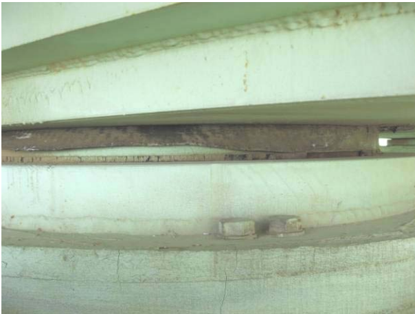
Figs. 7a y 7b: Rebasamiento de la lámina de teflón (PTFE) del apoyo tipo POT (izquierda). Rasgado y expulsión de la lámina de teflón (derecha). En ambos casos, el coeficiente de rozamiento menor del 5% no se puede garantizar, suponiendo un mayor bloqueo del esperado en Proyecto, pudiendo causar daños en pilas y estribos, así como en sus cimentaciones.
