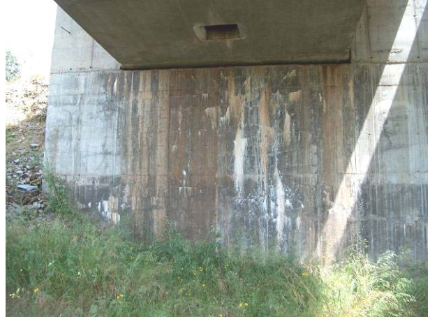
Figs. 10a y 10b: Daños producidos por la circulación de agua a través de la junta de calzada. En la derecha desarrollo de ataque por sulfatos en el hormigón. En la izquierda, humedades con oxidación de armaduras en zona de apoyo.
