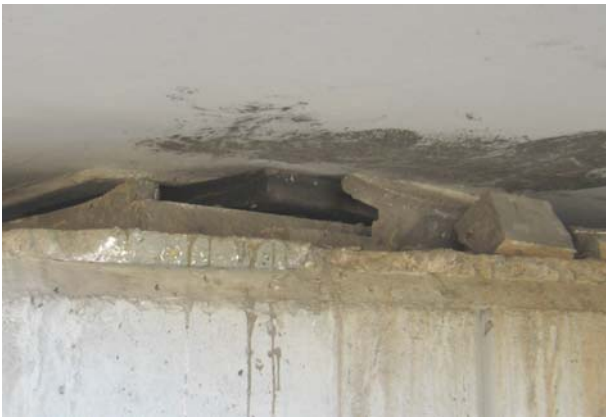
Figs. 5a y 5b: Deficiente puesta en obra de los aparatos de apoyo, con importantes errores de replanteo, nivelación y paralelismo entre las caras de apoyo, habiendo producido la reptación y expulsión de los aparatos de apoyo.
