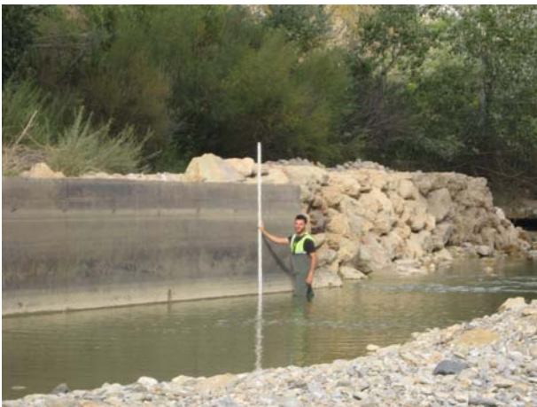
Figs. 3a y 3b: Erosión del termo circundante de la zapata por la presencia del curso del río en las inmediaciones de la cimentación. Escollera de protección colocada recientemente.
