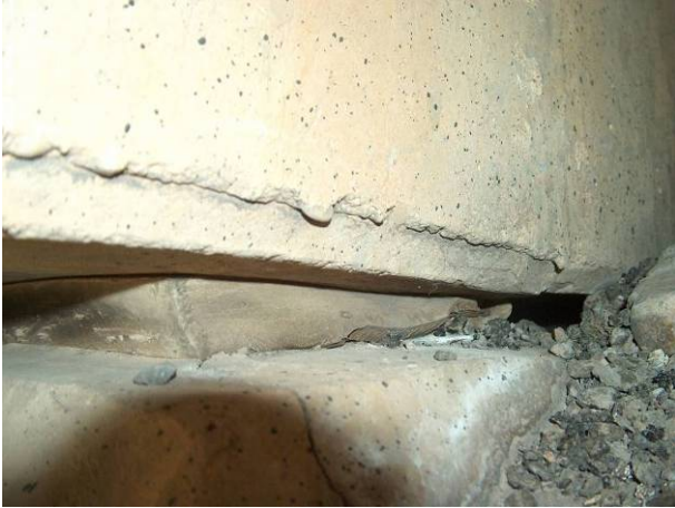
Figs. 4a y 4b: Rotura de neoprenos por la degradación del material con el paso de los años, resultando el apoyo totalmente ineficaz.
