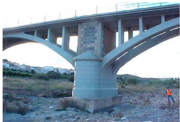
Figs. 2a y 2b: A la izquierda, fosa de socavación en un puente arco de fábrica. A la derecha, cimentación de pila afectada por la erosión general y local, en un puente arco de hormigón.
