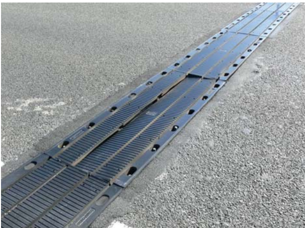
Figs. 11a y 11b: Junta de dilatación colocada descentrada por murete de guarda estricto. Debido al acortamiento de la estructura, el tramo central de la junta se queda apoyado únicamente en un lateral, produciendo inmediatamente la rotura del y el agotamiento de la junta.
