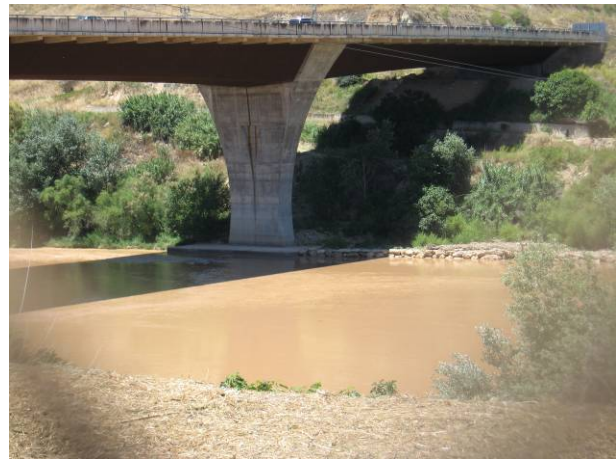
Figs. 3a y 3b: Erosión del termo circundante de la zapata por la presencia del curso del río en las inmediaciones de la cimentación. Escollera de protección colocada recientemente.
