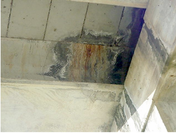
Figs. 10a y 10b: Daños producidos por la circulación de agua a través de la junta de calzada. En la derecha desarrollo de ataque por sulfatos en el hormigón. En la izquierda, humedades con oxidación de armaduras en zona de apoyo.
