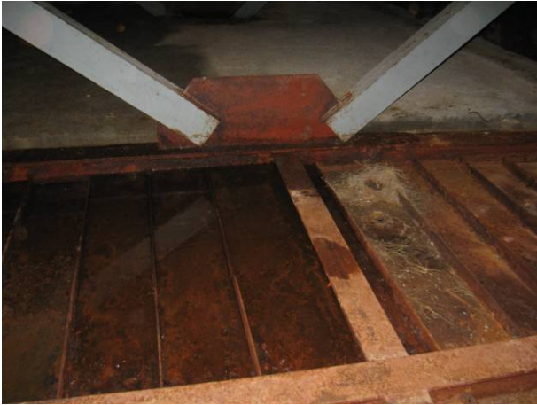
Figs. 14a y 14b: Interior de un cajón mixto de acero corten con importantes filtraciones de agua, habiendo degenerado en el deterioro del sistema de pintura y la oxidación del acero corten, al no ser capaz éste de generar la capa de pátina debido a la falta de ventilación, la alta humedad interior y la condensación interior.
