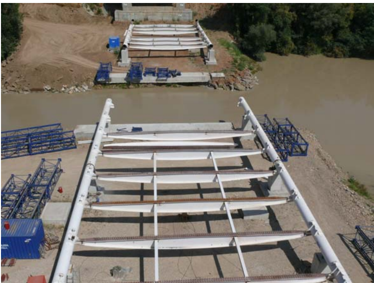
Fig. 8: Vista de las penínsulas artificiales y de las labores de ensamblaje de la estructura metálica del tablero
