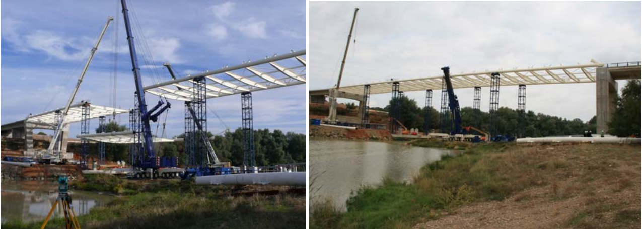
Figs. 9a y 9b: Izado de un tramo de tablero y vista del tablero metálico del puente concluido y apeado
