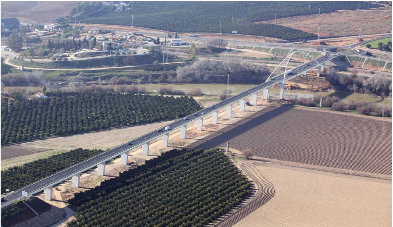
Fig. 1: Vista aérea en primer plano del Viaducto de acceso Sur, del Puente arco, del Viaducto de acceso Norte y de la glorieta.
