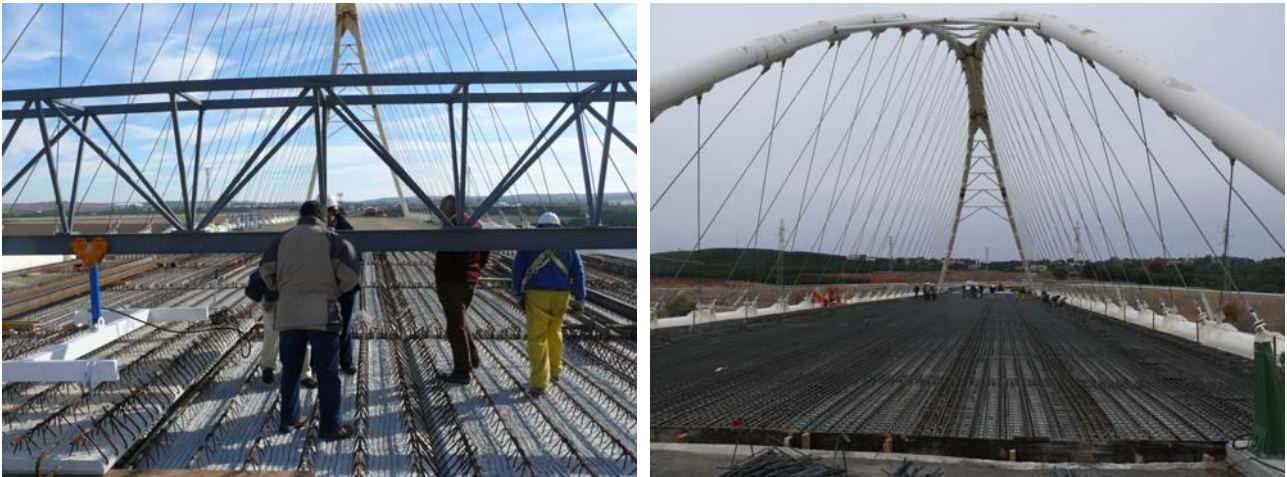
Figs. 11a y 11b: Vista durante las operaciones de colocación de prelasas en el tablero y con el tablero ferrallado.
