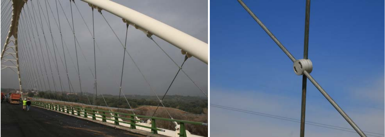
Figs. 13a y 13b: Detalle de péndolas en dos planos paralelos con los dispositivos de cruce de péndolas
