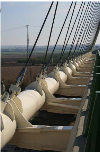
Figs. 5a y 5b: Detalles de anclajes de péndolas inferiores y arranques de vigas trasversales dispuestas cada 5 m en el tablero
