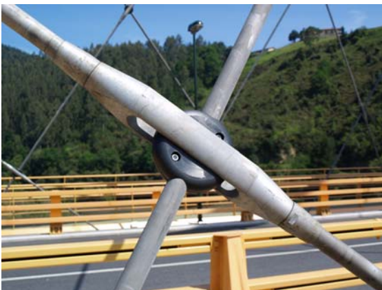
Figs. 10a y 10b Detalle del cruce de péndolas inclinadas y montaje
