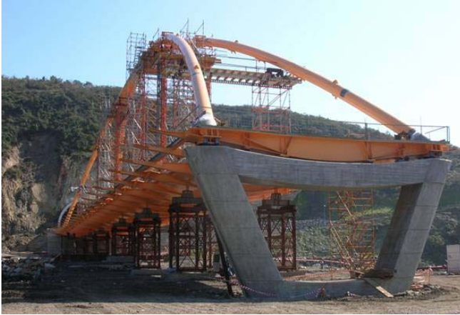
Fig. 15 Vista del arco y tablero apeados
