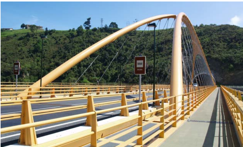
Fig. 4 Vista de las aceras voladas laterales
