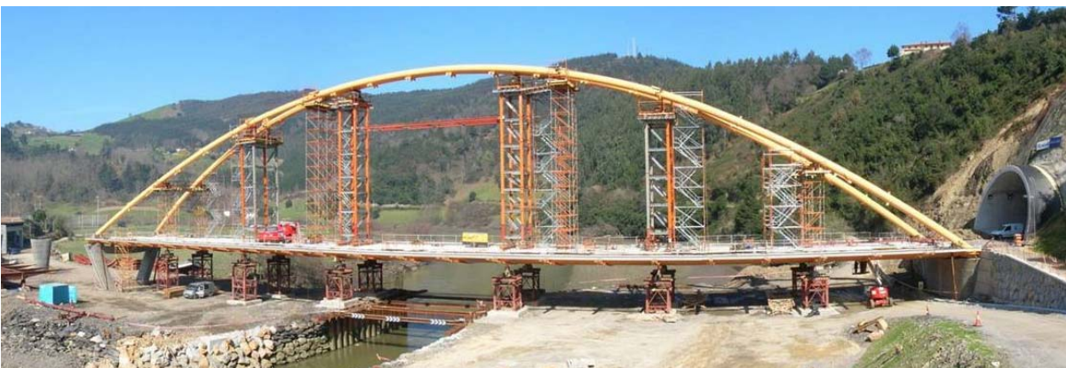
Fig. 14 Vista del arco y tablero apeados
