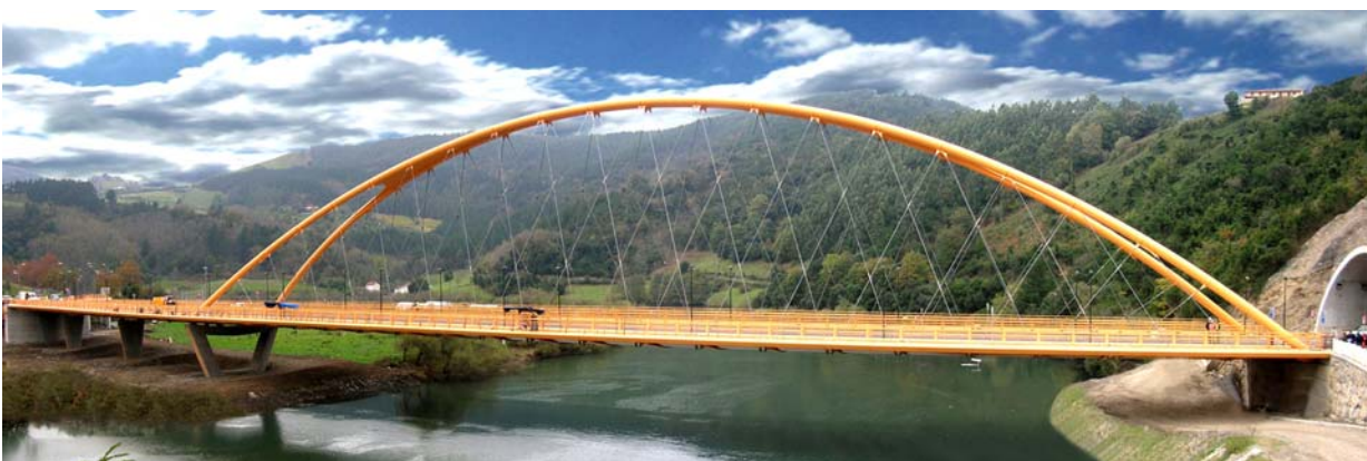
Fig. 5 Vista desde aguas abajo
