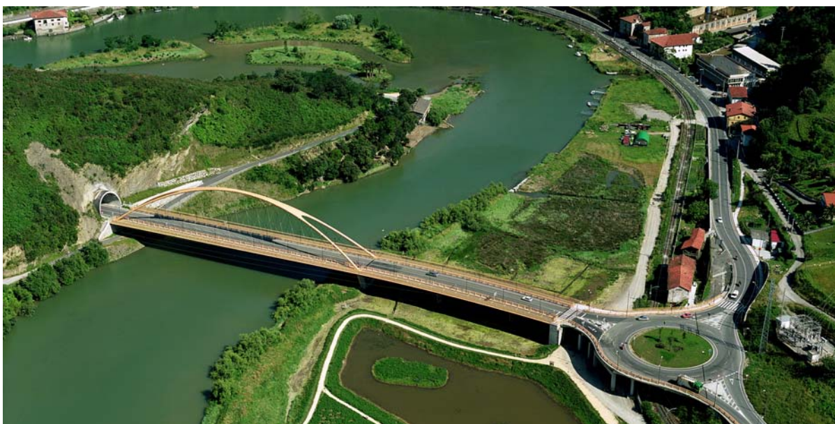
Fig. 1 Vista aérea del puente y del viaducto de acceso
