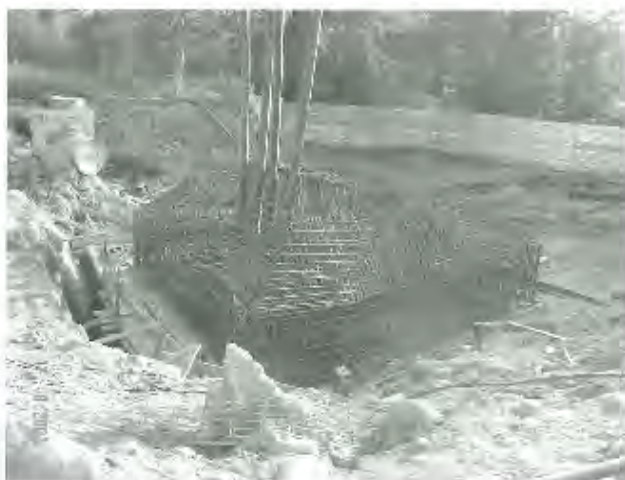
Figura 7. Ferralla de pila.
