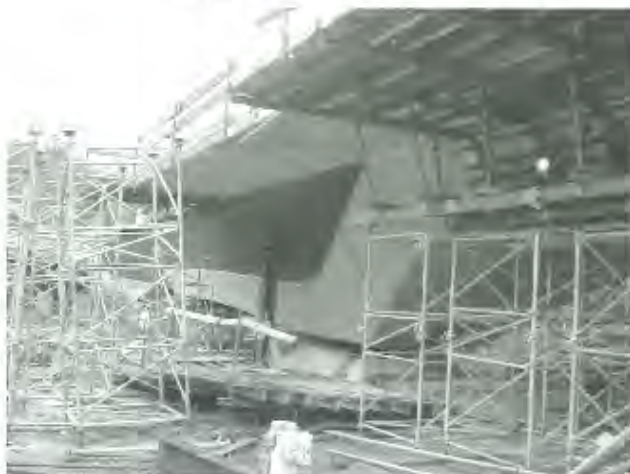
Figura 8. Descimbrado de vanos laterales.
