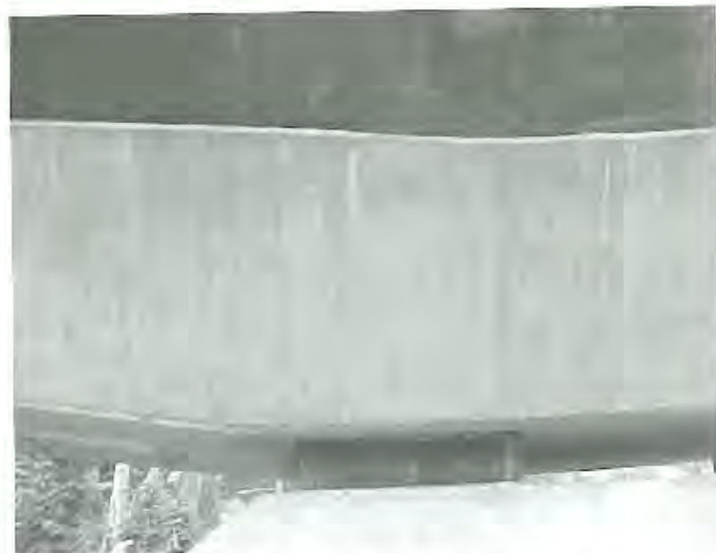
Figura 12. Vista de zona de apoyo del puente en pila.
