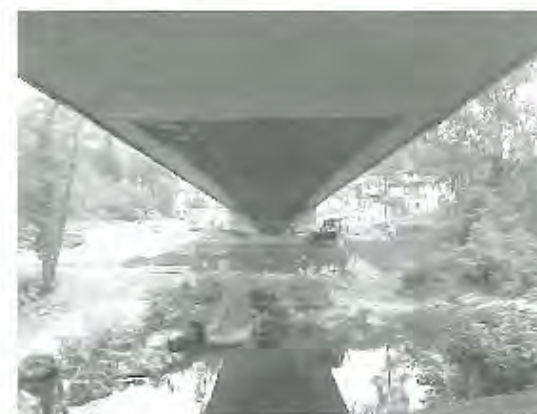
Figura 6. Vista inferior de tablero.
