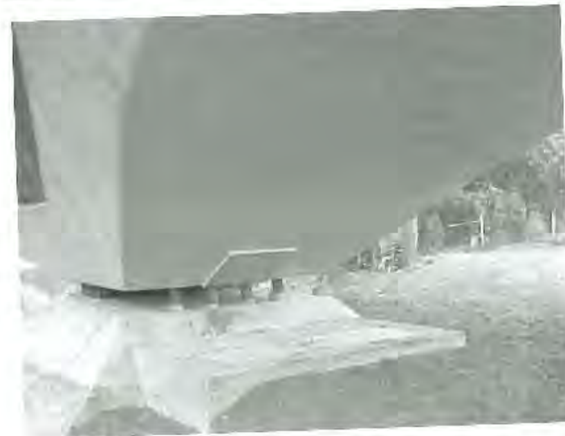
Figura 13. Acceso tanto en tablero como en pila a pretensado vertical.
