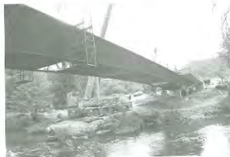
Figura 9. Colocación tramo central del metal.
