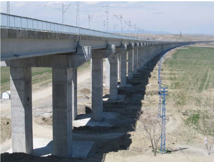
Fig. 1: Vista lateral del Viaducto 4 concluido
