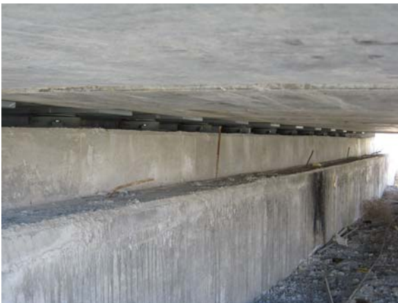
Fig. 15: Vista de los apoyos tipo POT libres
