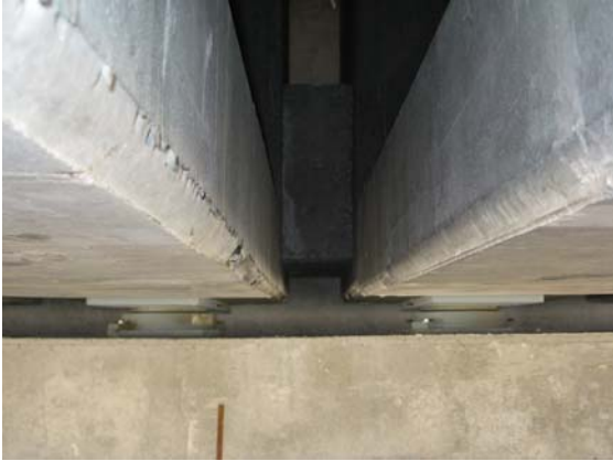
Fig. 12: Viga riostra entre cabezas inferiores de vigas
