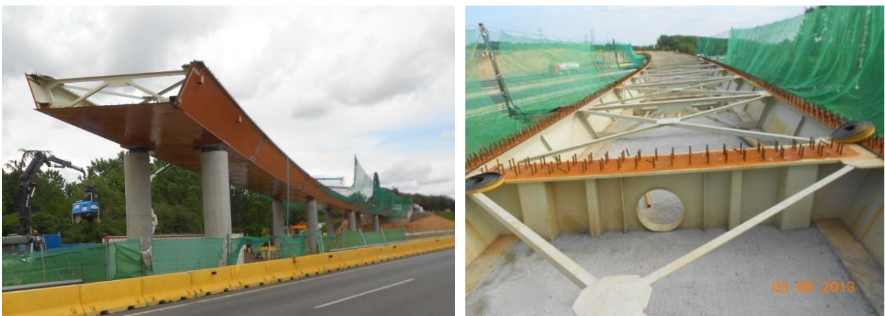
Figuras 6a y 6b. Vista del cajón metálico de la estructura E1 en ejecución sobre la AP-7 (izq.), y detalle del hormigón de fondo en zonas de momentos negativos (der.)
