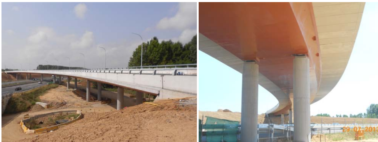
Figura 7. Imágenes de la E-1 concluida
