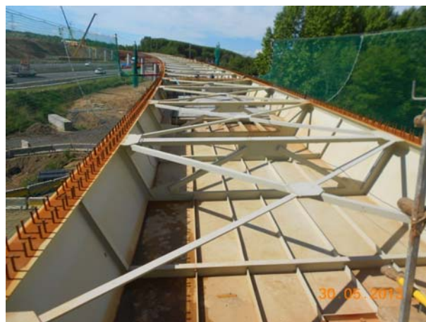
Figura 4. Vista del cajón metálico en ejecución
