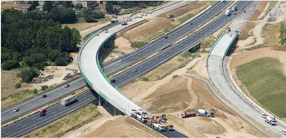
Figura 1. Vista aérea de los dos viaductos, la E-1 a la izquierda sobre la AP-7 y la E-2 a la derecha
