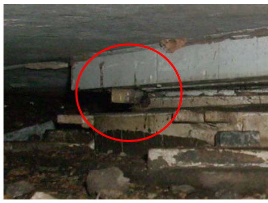
Figuras 6 y 7. Detalle de los tornillos de anclaje de las bandejas deslizantes topando con los pistones de los apoyos.
