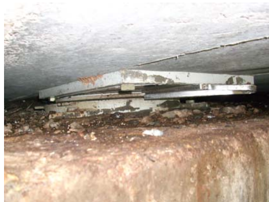
Figuras 4 y 5. Aparatos de apoyo correspondientes al estribo 1. Apoyos con carrera totalmente agotada para un desplazamiento total de unos 22 cm. En la imagen izquierda se puede observar la rotura de la lámina lateral de la guía.
