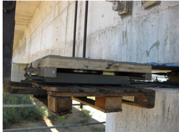
Figura 19. Detalle de colocación de apoyos en pila.
