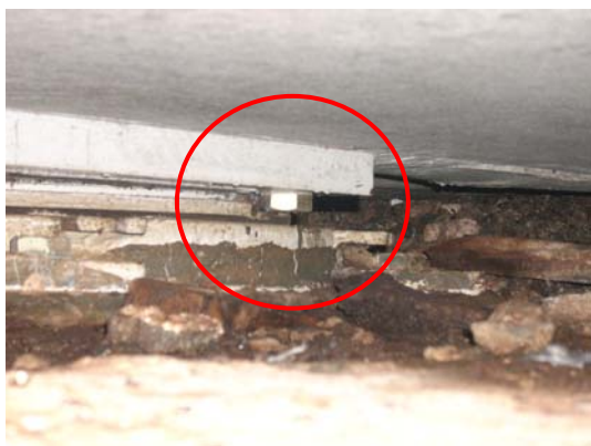
Figuras 6 y 7. Detalle de los tornillos de anclaje de las bandejas deslizantes topando con los pistones de los apoyos.
