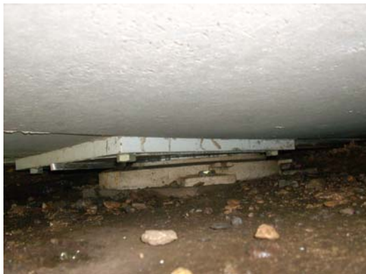
Figuras 4 y 5. Aparatos de apoyo correspondientes al estribo 1. Apoyos con carrera totalmente agotada para un desplazamiento total de unos 22 cm. En la imagen izquierda se puede observar la rotura de la lámina lateral de la guía.
