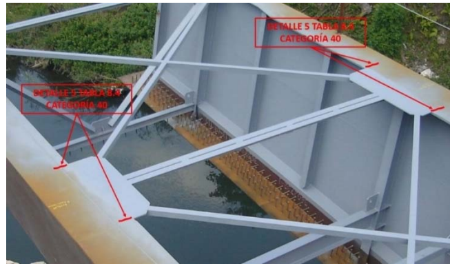
Figura 8 Detalles con categoría 40 (detalle 5 de tabla 8.4 de UNE-EN 1993-1-9 [1])
