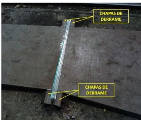
Figura 2 Chapas de derrame provisionales
