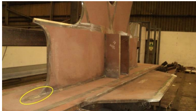
Figura 7 Detalle con categoría 80 con acabado amolado tangente (detalle 3 de la tabla 8.4 [1])
