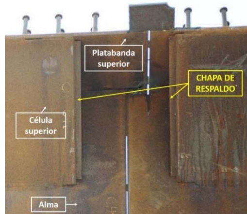
Figura 1 Chapas de respaldo en soldadura de una célula sin acceso al interior de la raíz
