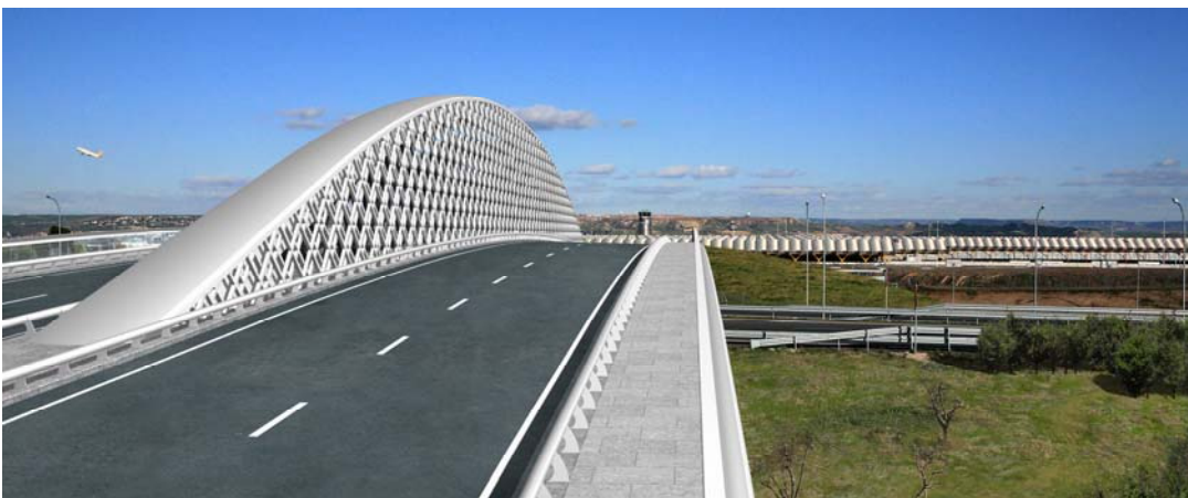
Figura 2. Vista desde el tablero del arco y 'diagrid'
