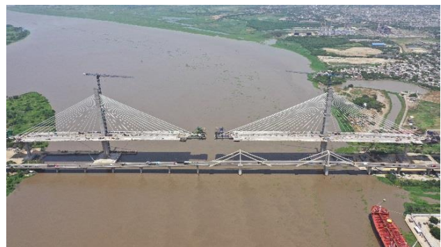
Figura 12. Vista aérea del puente en construcción
