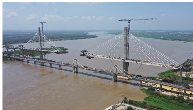
Figura 7. Vista lateral del puente durante su construcción)
