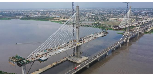
Figura 4. Vista de los carros de avance por voladizos sucesivos y los carros de alas 3 dovelas por detrás
