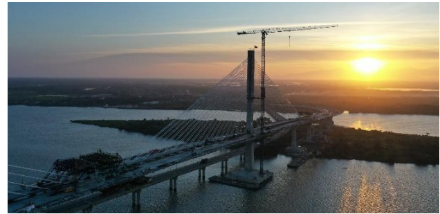
Figura 13. Vista aérea tras la ejecución de la dovela de cierre
