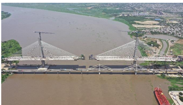
Figura 9. Vista aérea del puente en construcción
