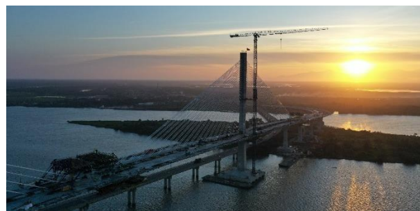
Figura 10. Vista aérea tras la ejecución de la dovela de cierre
