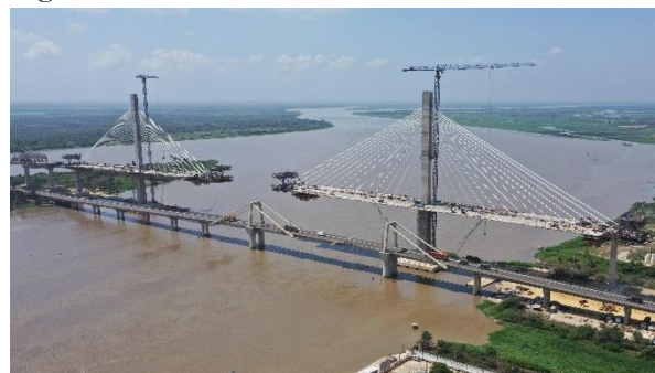
Figura 3. Vista lateral del puente durante su construcción
