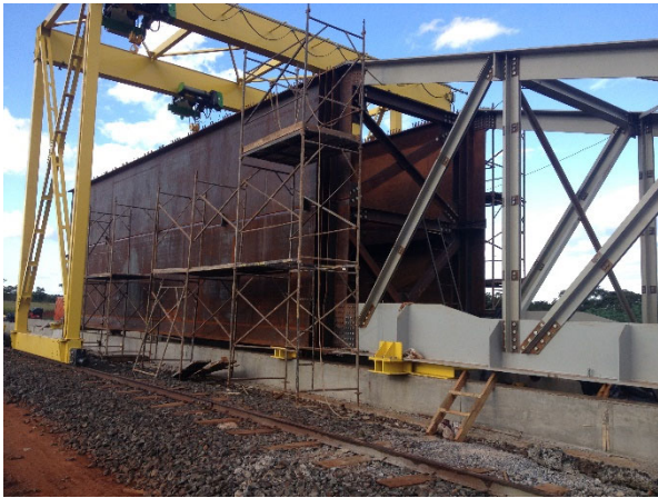
Figura 8. Primera dovela y nariz en el parque de empuje
