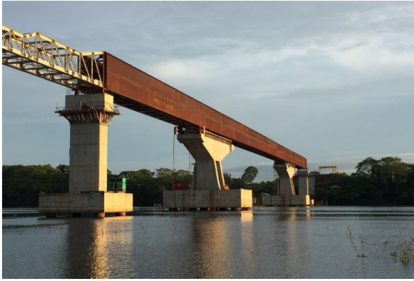
Figura 12. Viga metálica al final del empuje.
