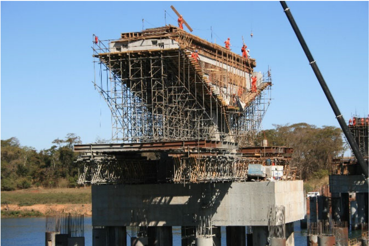
Figura 7. Pila central durante la construcción
