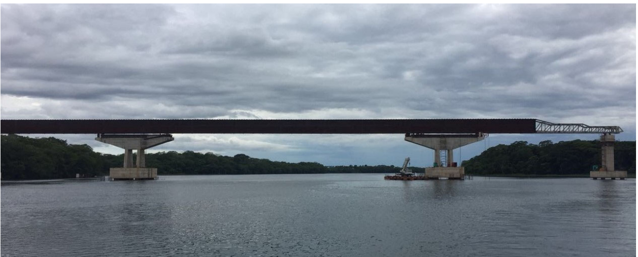
Figura 14. Alzado del puente durante el empuje.
