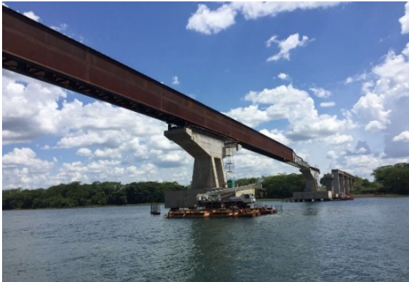
Figura 13. Empuje del vano principal
