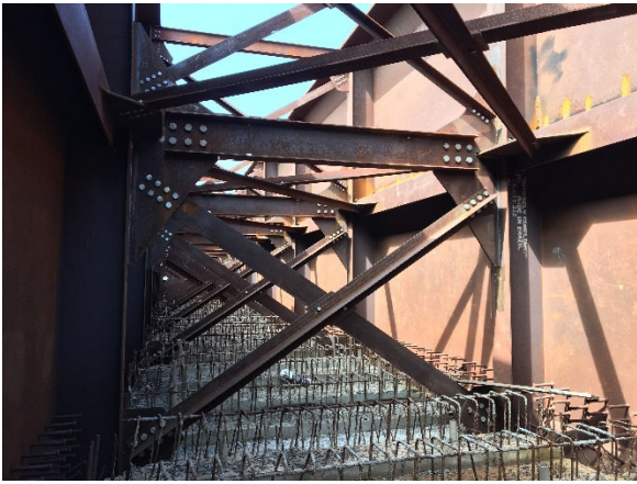
Figura 3. Vista del interior del cajón
