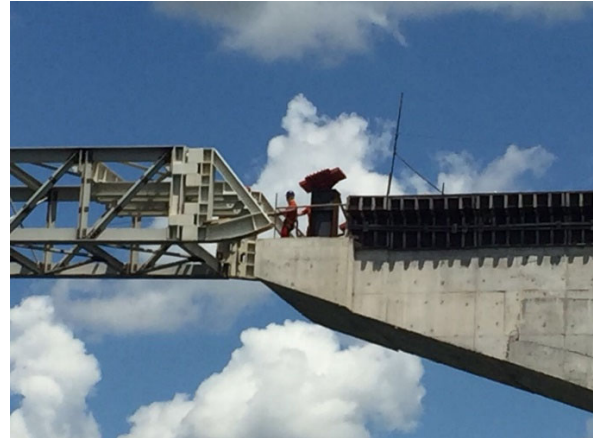
Figura 9. Nariz de empuje llegando a una pila central
